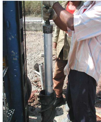
(d) Amostrador sendo inserido dentro do trado oco
