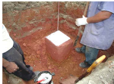
(c) Processo de proteção do bloco
