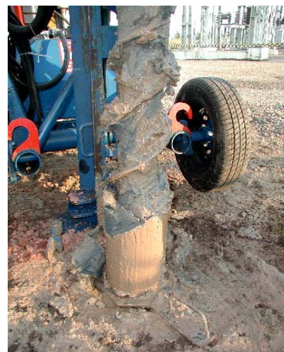
(b) Perfuração na camada de argila pré-furo
