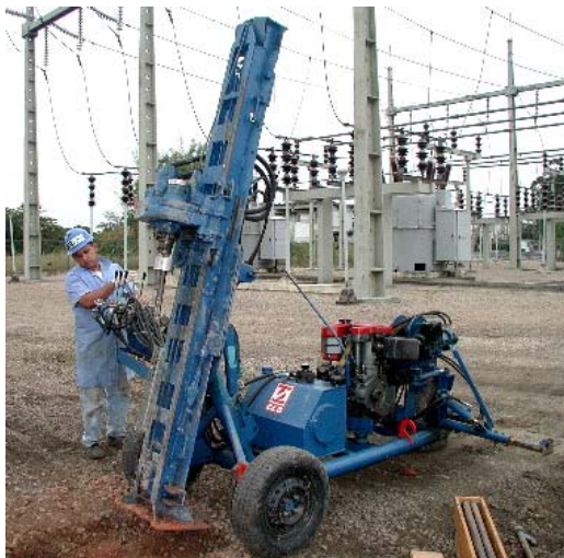
(a) Posicionamento da perfuratriz para executar o pré-furo
