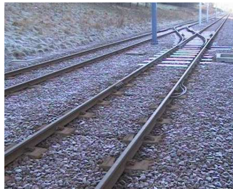
2.4(d): Ferrovia com dormentes na forma de blocos de concreto sobre um lastro granular
