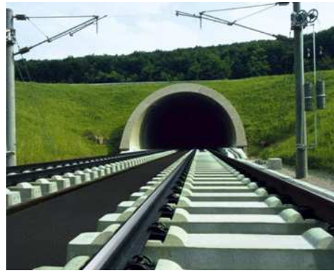
2.4(b): Ferrovia com dormentes de concreto, Alemanha
