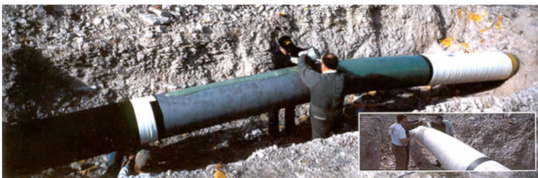
Figura 2-1 – Aplicação do produto in loco – Strongback .
