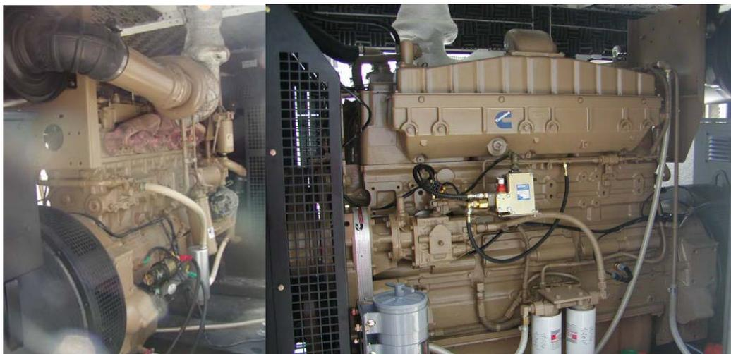
Figura 21: Grupo gerador com motor Cummins NTA855G3.
