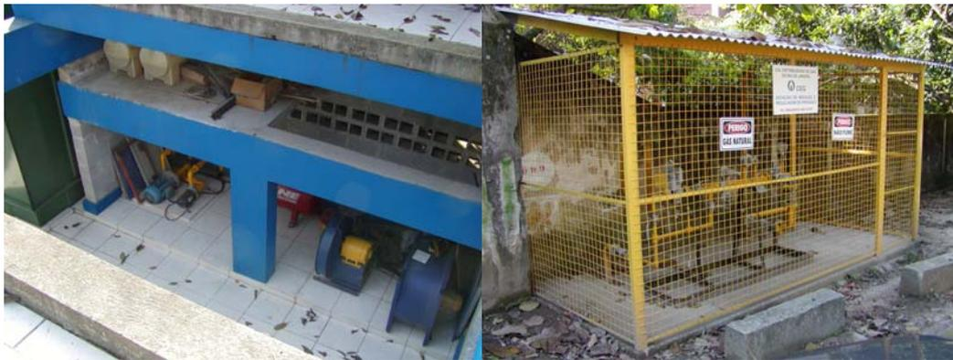
Figura 14: Tanques de Diesel, bombas d'água (dinamômetro e inter-resfriador), insuflamento de ar fresco e estação para regulagem e medição de gás natural.
