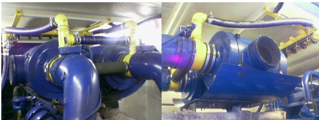
Figura 24: Sistema para dosagem de gás aos Perkins 4012 TAG2.
