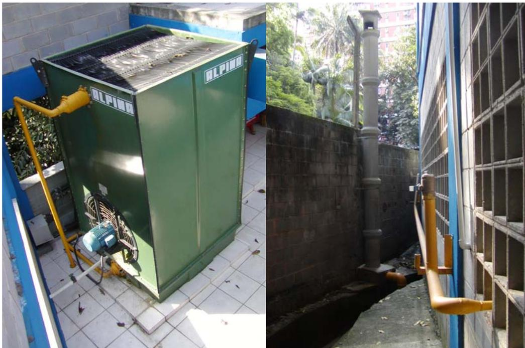
Figura 13: Torre de resfriamento, escape do laboratório e rede de distribuição de gás natural encanado.
