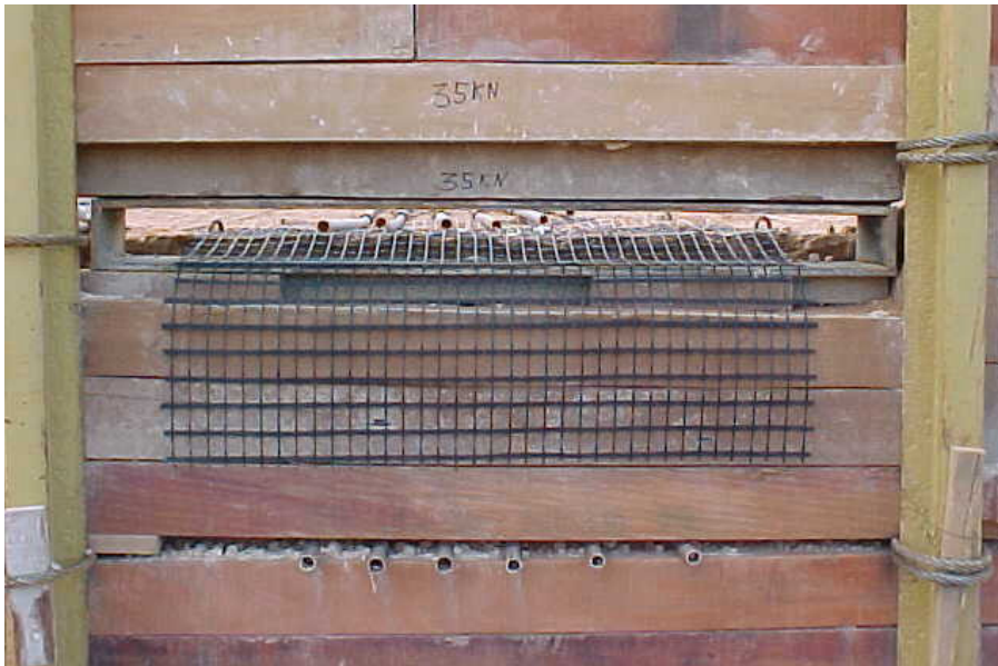
Figura 107 - Detalhe da extremidade da amostra de geogrelha e dos tubos de saída dos tell-tales da amostra posicionada do lado oposto do aterro.
