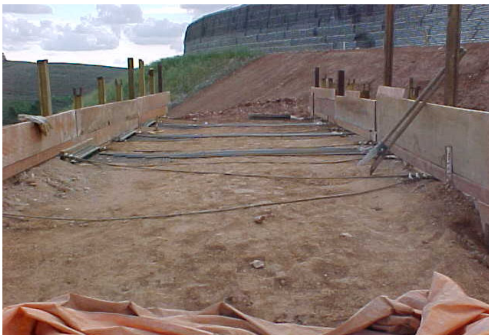
Figura 103 - Camada de solo compactado, nivelada, com três amostras de geogrelha instaladas.
