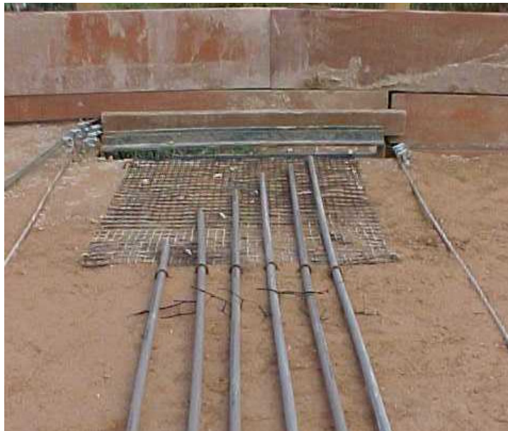
Figura 105 - Vista da amostra de geogrelha instrumentada imediatamente antes do lançamento da camada de solo sobrejacente.
