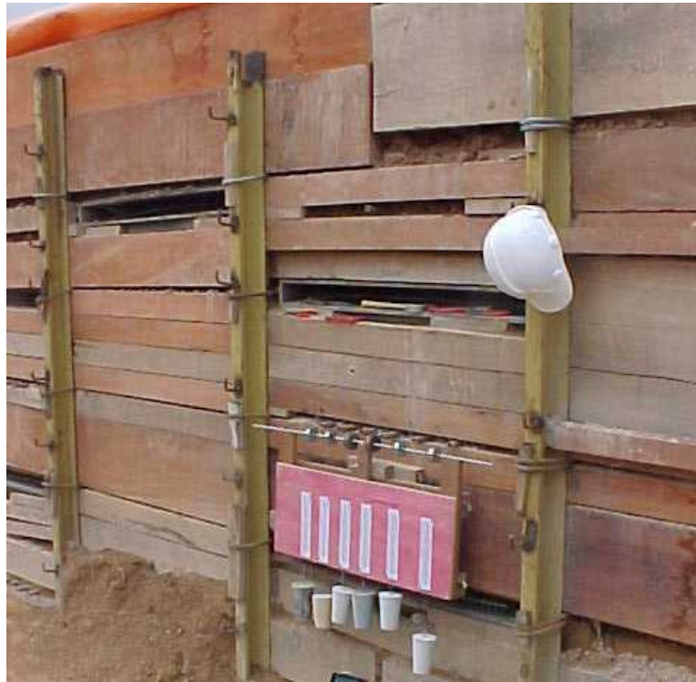
Figura 108 - Vista da face do aterro com o sistema de leitura dos tell-tales de uma geogrelha instalada na face oposta.
