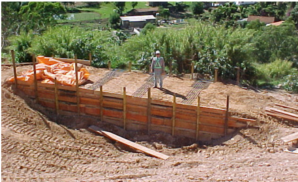
Figura 109 - Vista geral do aterro experimental em fase final de construção.
