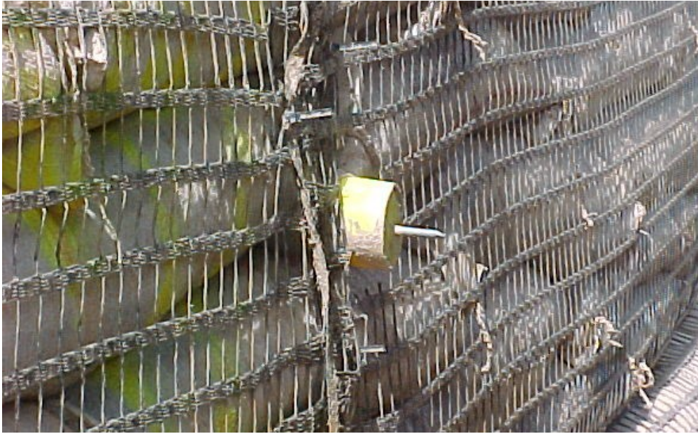
Figura 97 - Marco topográfico instalado na face do muro, entre duas camadas de sacaria.
