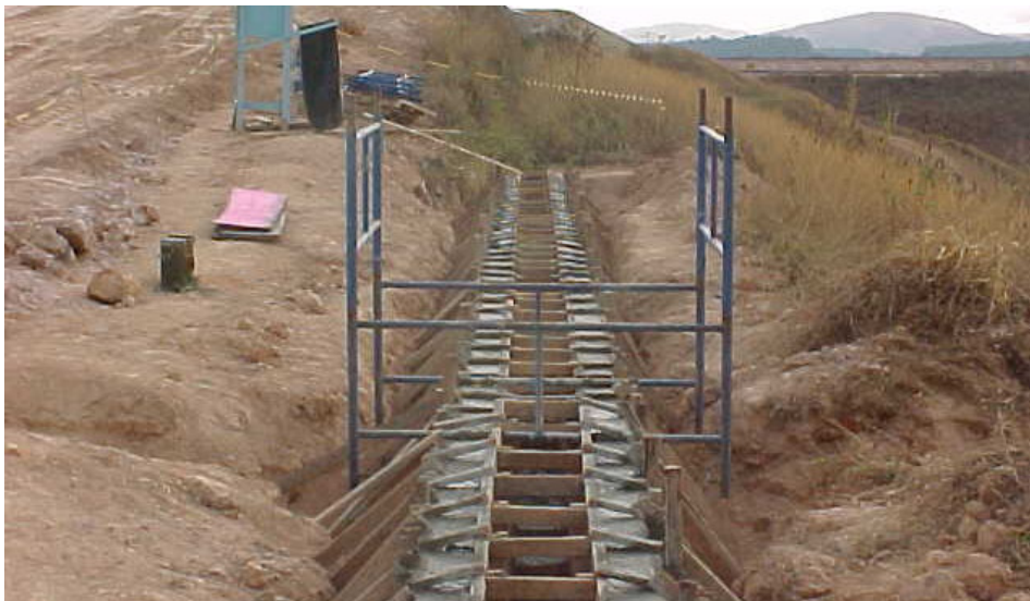
Figura 94 - Canaleta de drenagem recém concretada com os primeiros painéis de andaime já posicionados.
