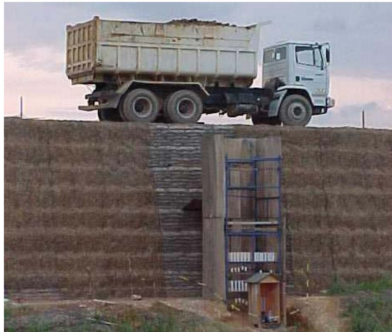
Figura 96 - Teste de sobrecarga realizado na seção E33+12, no muro já concluído.
