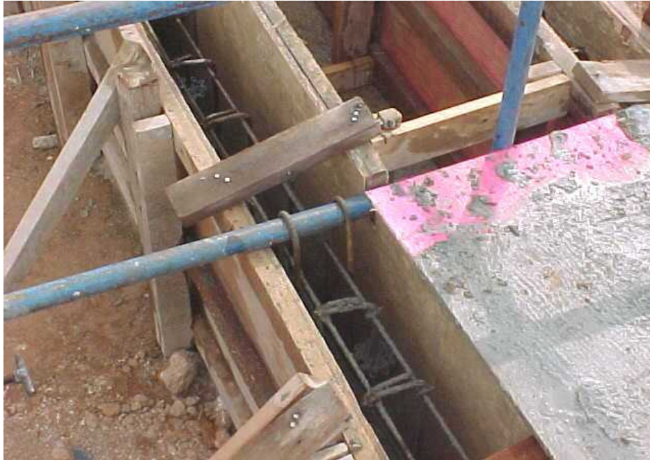
Figura 95 - Detalhe da fixação da base da estrutura na canaleta a ser concretada.
