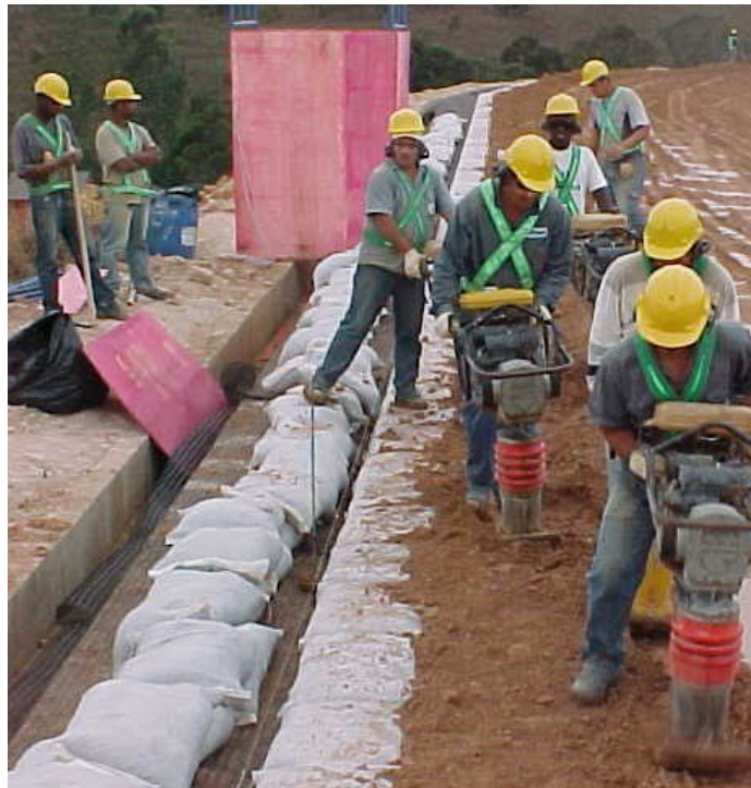
Figura 88 - Compactação do solo lançado próximo à sacaria por meio de “sapo”.
