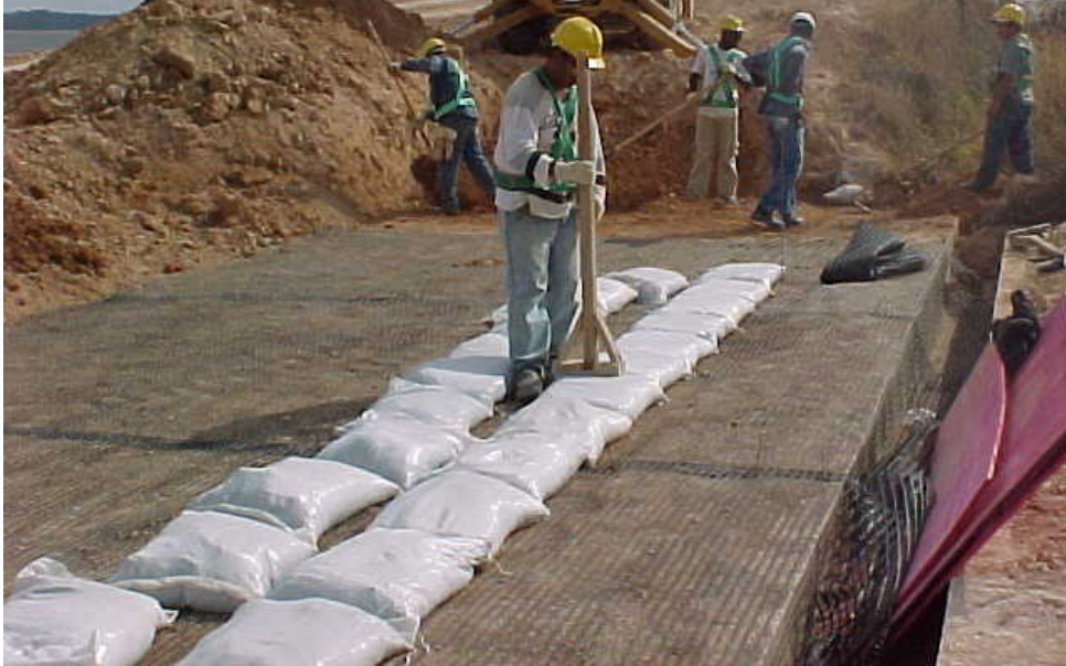
Figura 83 - Instalação da primeira camada de geogrelha do muro.
