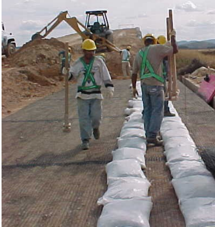
Figura 85 - Posicionamento da primeira fiada de sacaria assentada com soquetes manuais.
