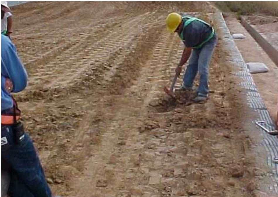
Figura 90 - Retirada de cilindro de metal cravado no solo para realização de controle de compactação.
