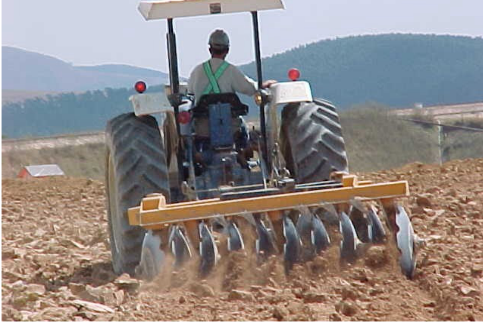
Figura 87 – Gradeamento para redução e uniformização da umidade da camada de solo lançada.
