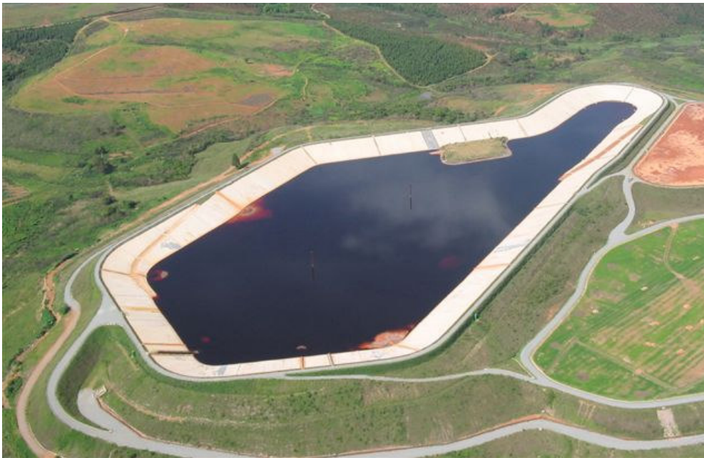
Figura 82 – Vista aérea do DRB#7 em operação.
