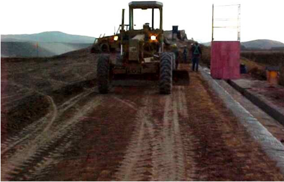
Figura 91 - Nivelamento de camada compactada por meio de moto-niveladora para permitir o lançamento de uma nova camada de geogrelha.
