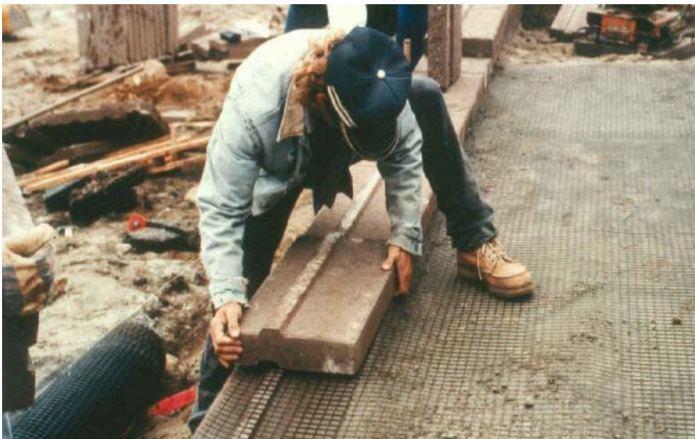
Figura 8 - Muro de solo reforçado com geogrelha e face em blocos de concreto, segundo Bathurst (2002).
