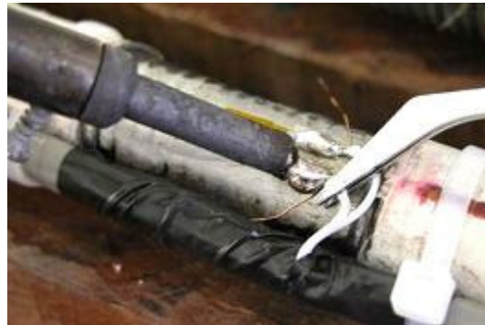
b) soldagem dos fios do cabo ao terminal
