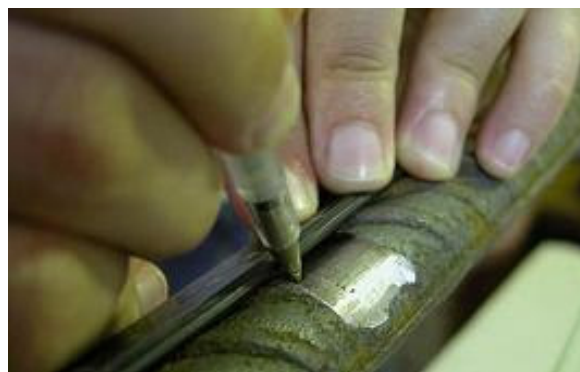
Figura 54 – Marcação do alinhamento das Barras CA50
