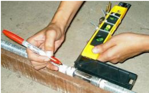
a) marcação dos pontos de alinhamento nivelados
