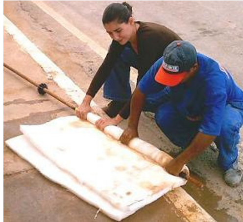
Figura 47 - Colocação de espuma na barra de aço para garantia do trecho livre
