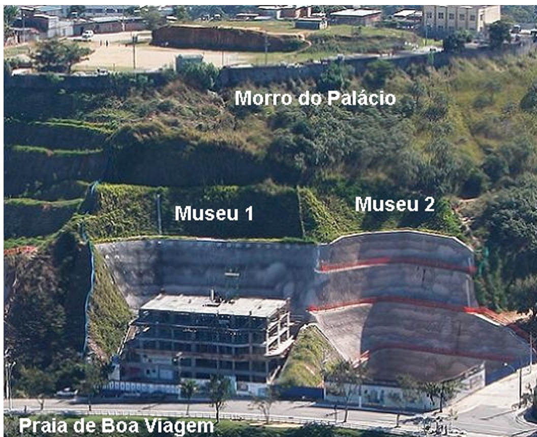
b) detalhes das obras Museu 1 e 2
