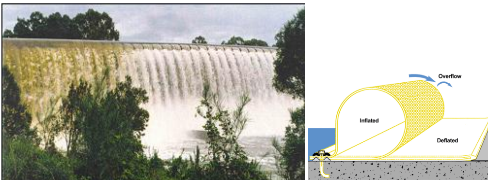
Figura 2.15– Alteamento com elemento inflável de borracha (Bureau of Reclamation, 1992).
