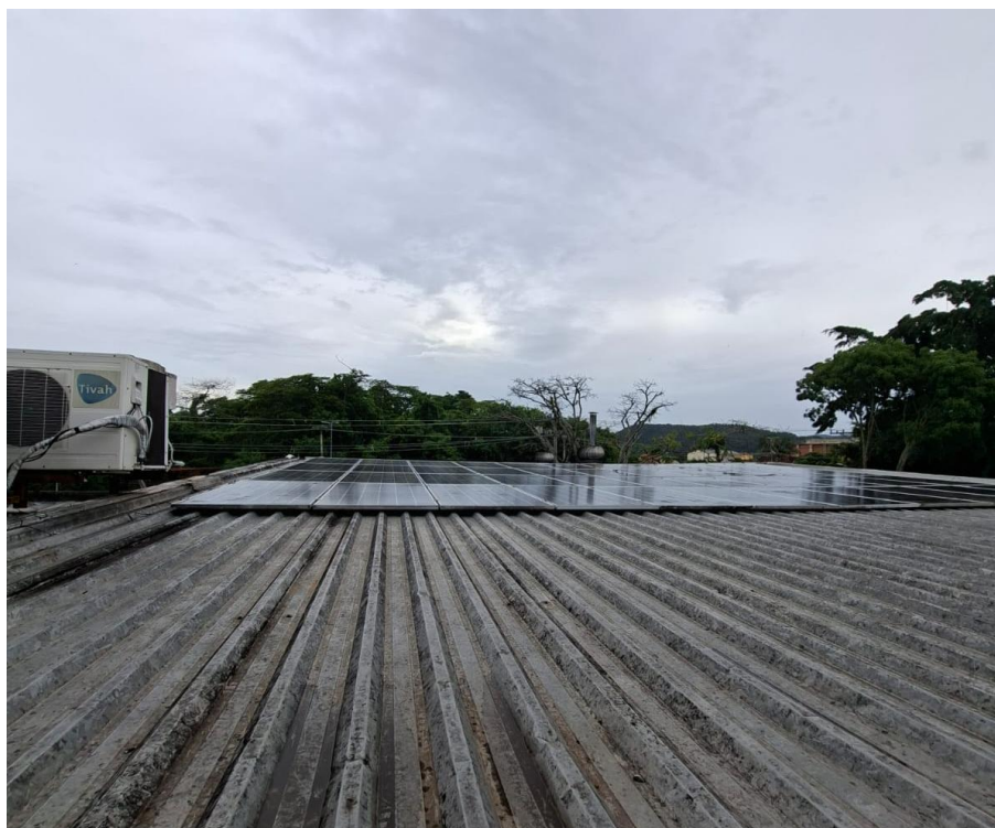
Figura 4 - Painéis fotovoltaicos em fase de implementação na Cervejaria Máfia
