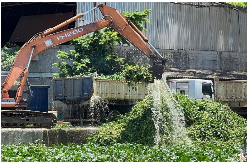
Figura 5- Operação de coleta da macrófita na ecobarreira do Itanhangá. Fonte: acervo pessoal, 2021.
