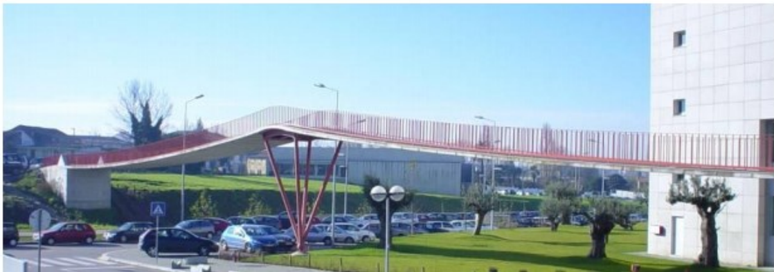
Figura 9 – Passarela da Universidade do Porto (Caetano e Cunha, 2004)
