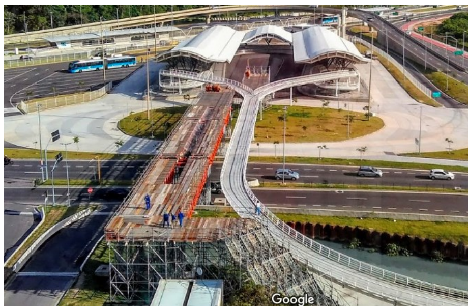
Figura 16 – Estrutura provisória ao lado da passarela do Terminal Centro Olímpico [Fonte: Google Maps, 2017]
