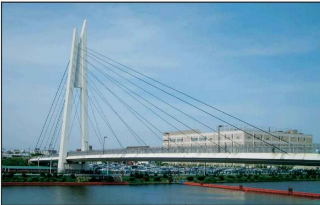
Figura 3 – Toda Park Bridge, Toda City/Japão (Nakamura & Fujino, 2002)
