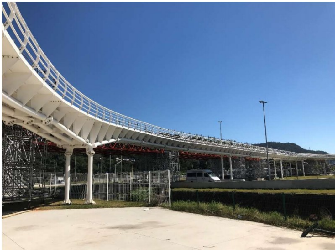
Figura 19 – Passarela Terminal Centro Olímpico: Trecho 2 (Dias e Souza, 2017)
