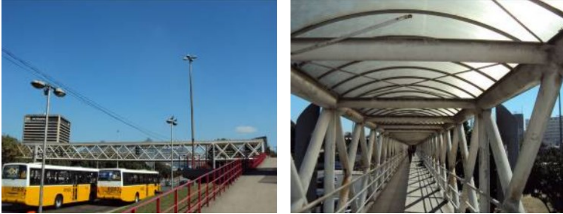
Figura 11 – Passarela Osvaldo Aranha (Zúñiga, 2011)
