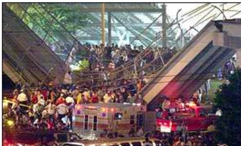
Figura 1 – Desabamento da passarela na Carolina do Norte/EUA [Fonte: BBC News]
