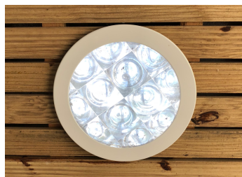
Figura 6.7: Luminária do produto Solatube instalada no campus da PUC-Rio. Fonte: Acervo Pessoal (2018).
