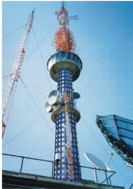
Figura 2.5 – Reforço da torre de transmissões da Rede Globo de Televisões (CURTY, 2009).
