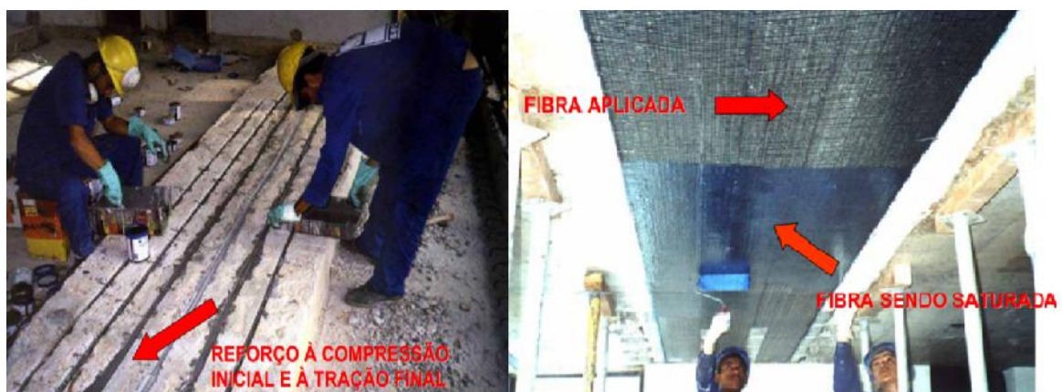
Figura 2.7 – Aplicação do reforço com CFC no edifício da secretaria de estado da fazendo de Minas Gerais. Fonte: Apresentação de Ari de Paula Machado na ABECE. Disponível em: < http://www.abece.com.br/e-artigosabece007.pdf > Consulta em 18/10/2018.
