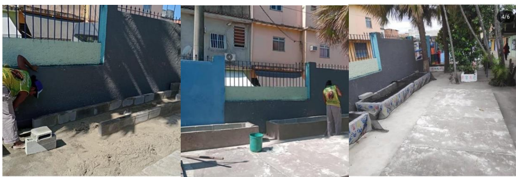
Figura 17: Construção do canteiro da Escola Gonzaguinha
