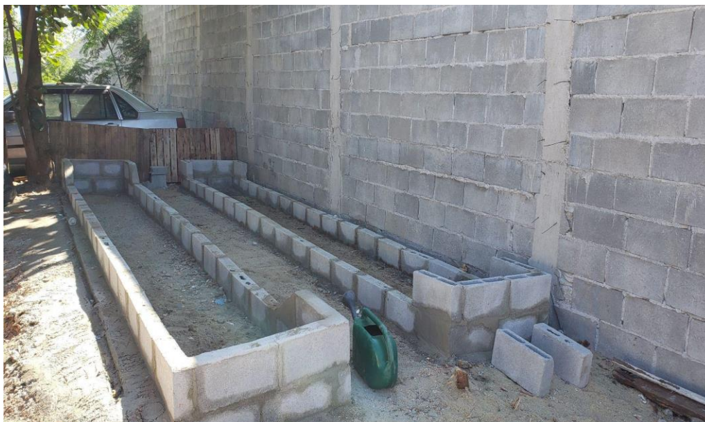
Figura 13: Construção dos Canteiros
