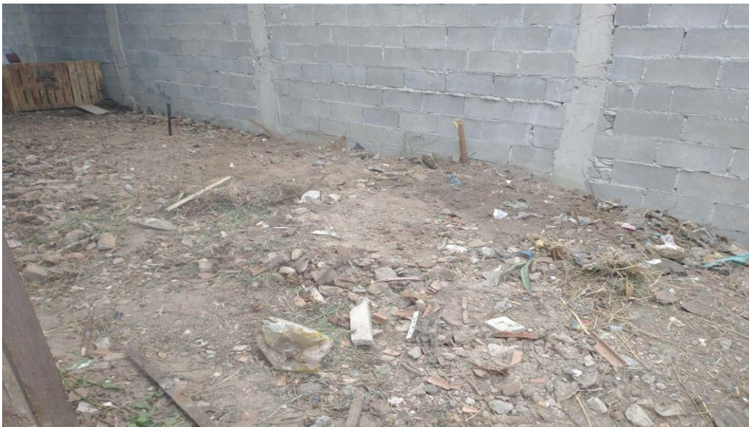
Figura 12: Terreno em manutenção
