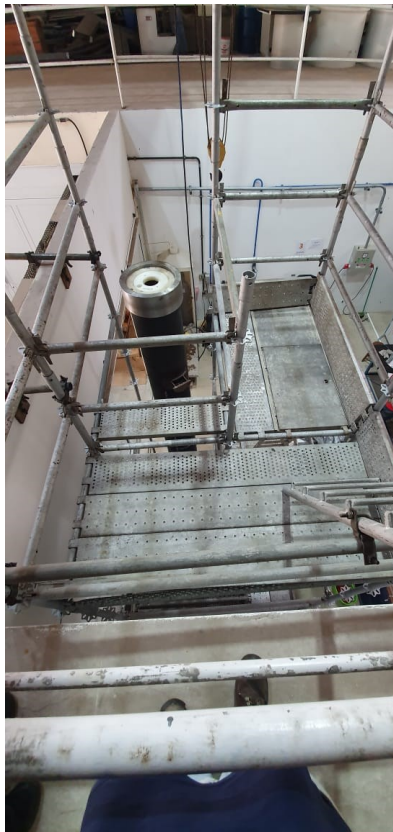
Figura 69: Vista do andaime.
