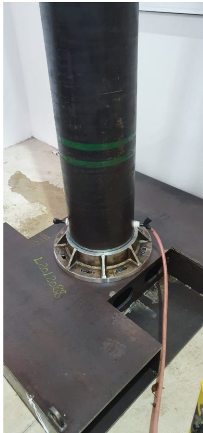
Figura 70: Torneira e mangueira para preenchimento e escoamento de fluido
