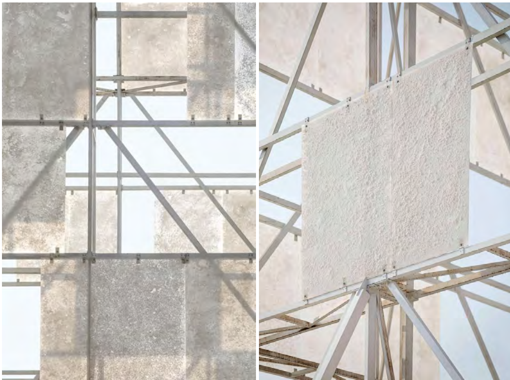
Figura 104 - Placas de sal na fachada
