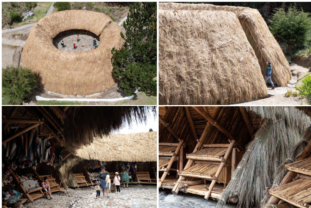
Figura 28 – Vistas externas e internas da Chaki Wasi
