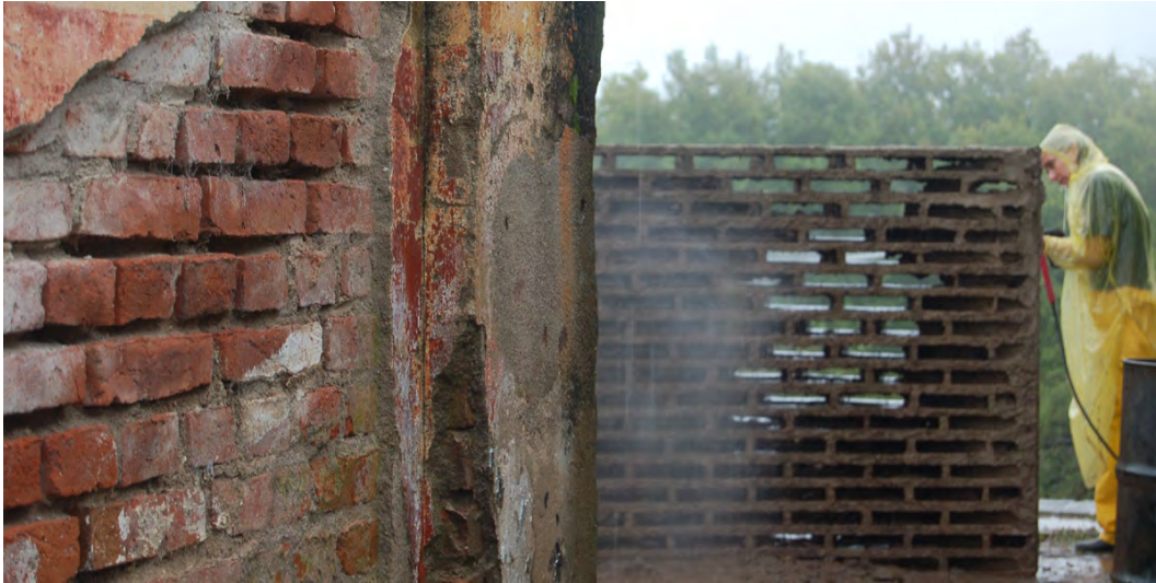
Figura 68 - Muro em contraposição à parede do estábulo Fonte: Ricardo Sargiotti / Rovea Sargotti Architettura
