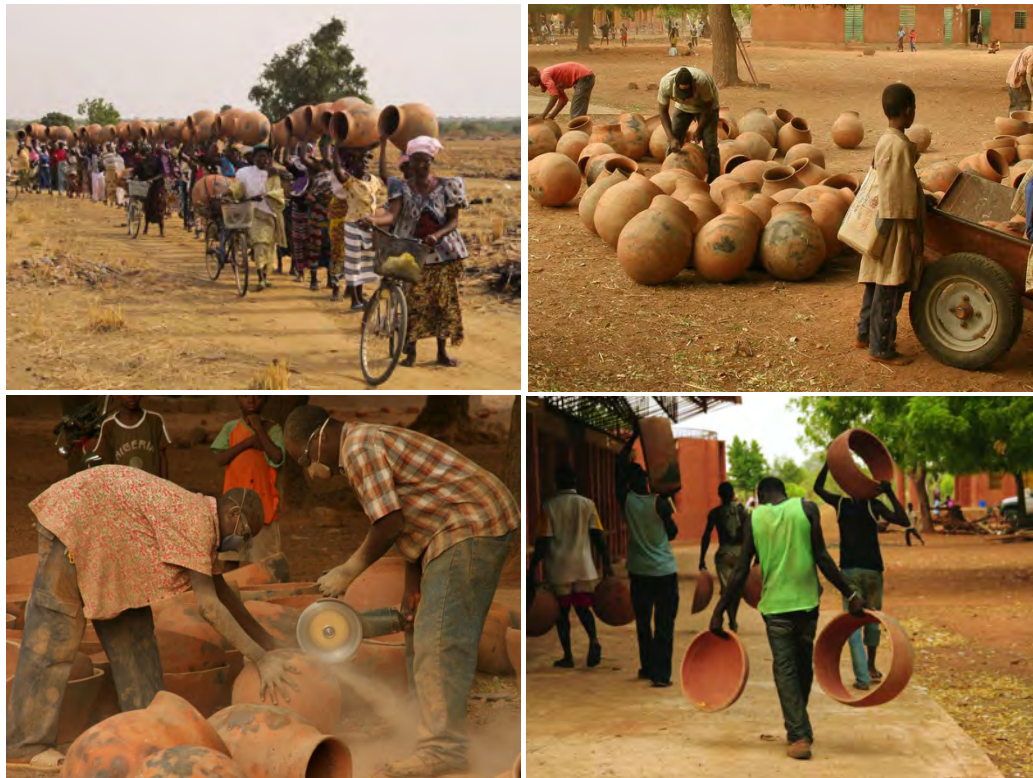
Figura 20 - Potes sendo transportados e cortados para o uso no teto da biblioteca
