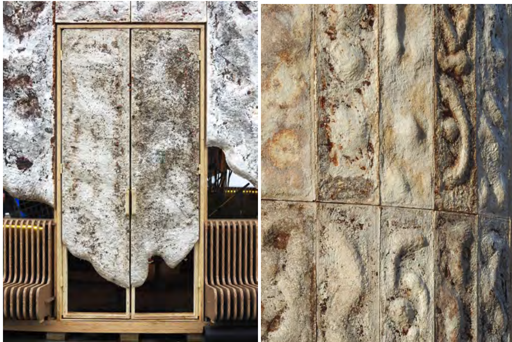
Figura 51 - Detalhe da porta e da fachada
