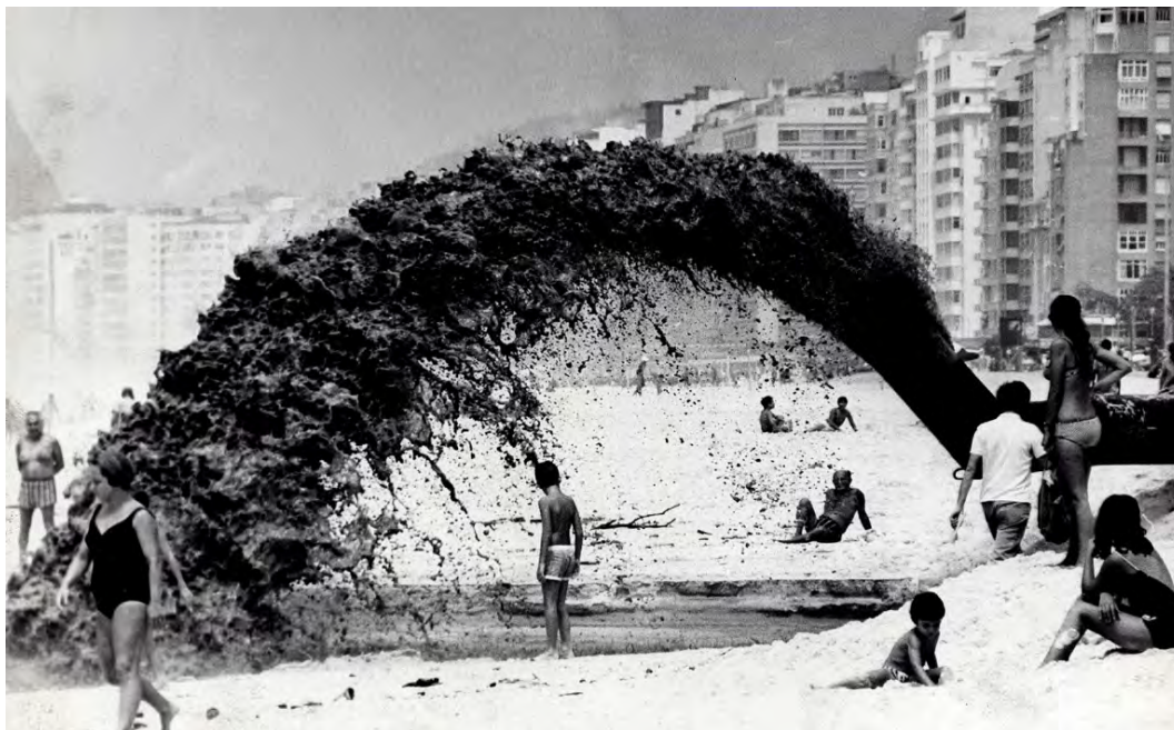
Figura 82 - Tubulação despejando areia na Praia de Copacabana, 1970
