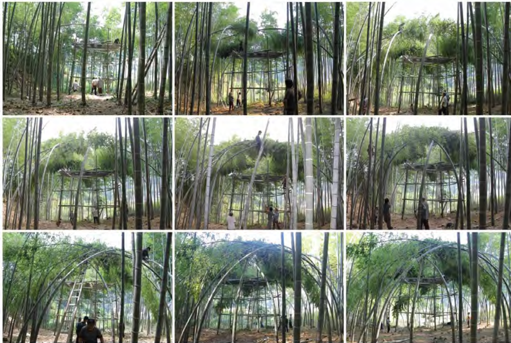
Figura 43 - Processo construtivo do teatro Fonte: Dan Han / ArchDaily
