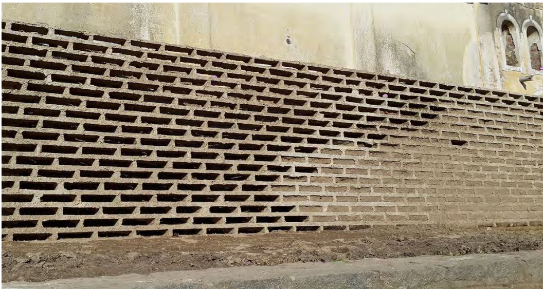
Figura 69 - Muro após o desmanche de parte dos tijolos de barro Fonte: Ricardo Sargiotti / Rovea Sargotti Architettura
