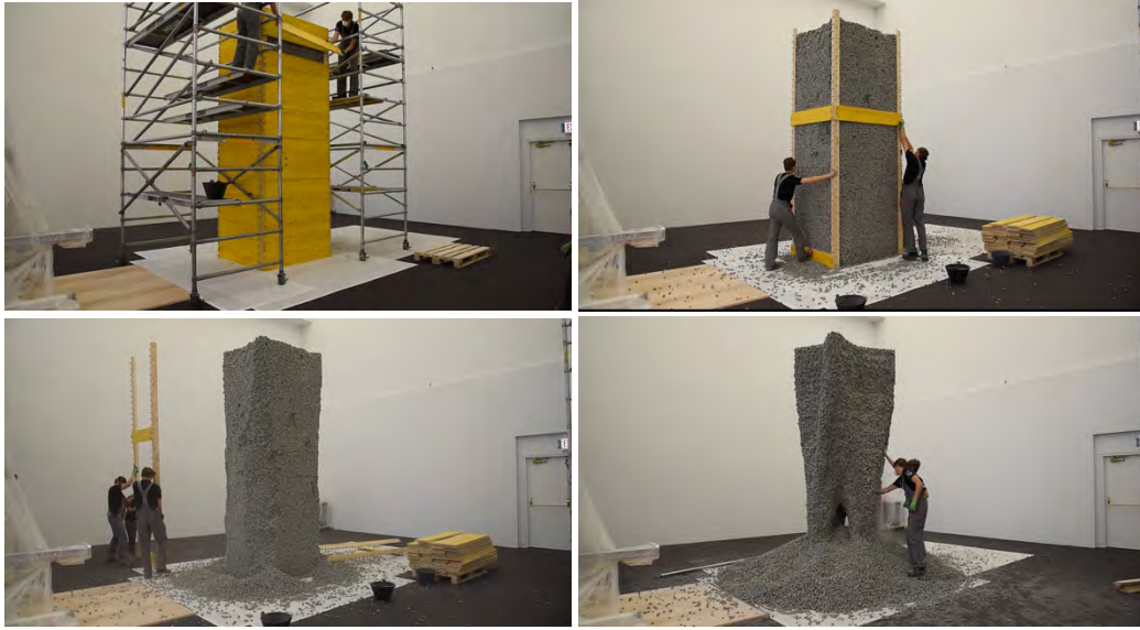
Figura 35 - Processo de desmoldagem após a impressão de todas as camadas Fonte: Gramazio Kohler Research
