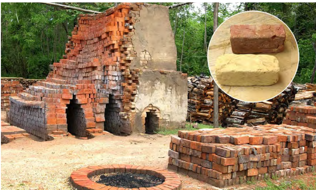
Figura 6 - Forno feito de tijolos crus empilhados em forma de pirâmide, tradicional da era colonial dos Estados Unidos
