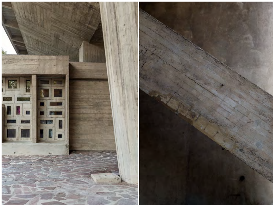
Figura 7 - Concreto aparente na Unite d' Habitation (Le Corbusier, 1952)
