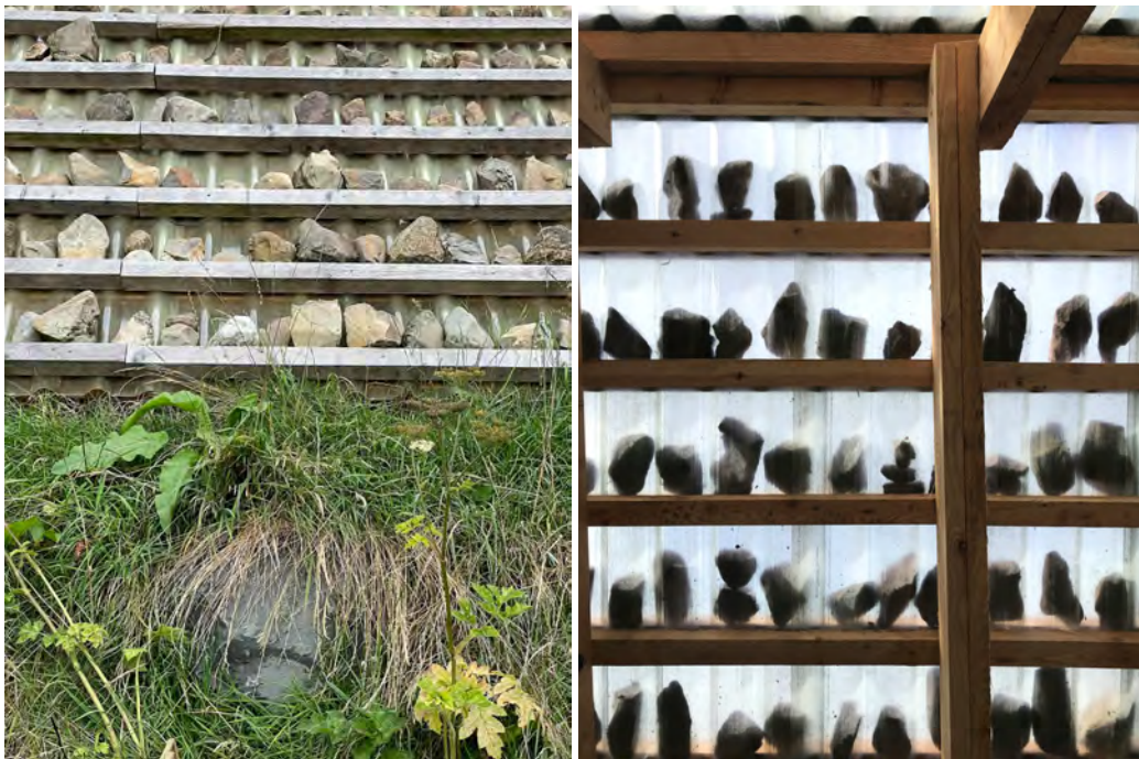
Figura 110 - Vista externa e interna das rochas sobre o telhado Fonte: Material Cultures
