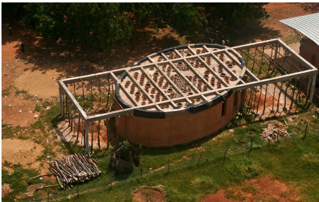
Figura 23 - Vista aérea da construção da estrutura de suporte do telhado
