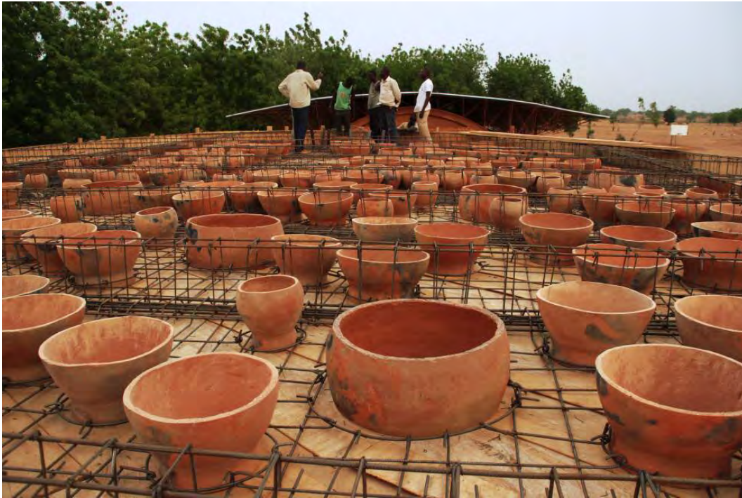
Figura 21 - Assentamento dos potes antes da concretagem da laje Fonte: Kéré Architecture
