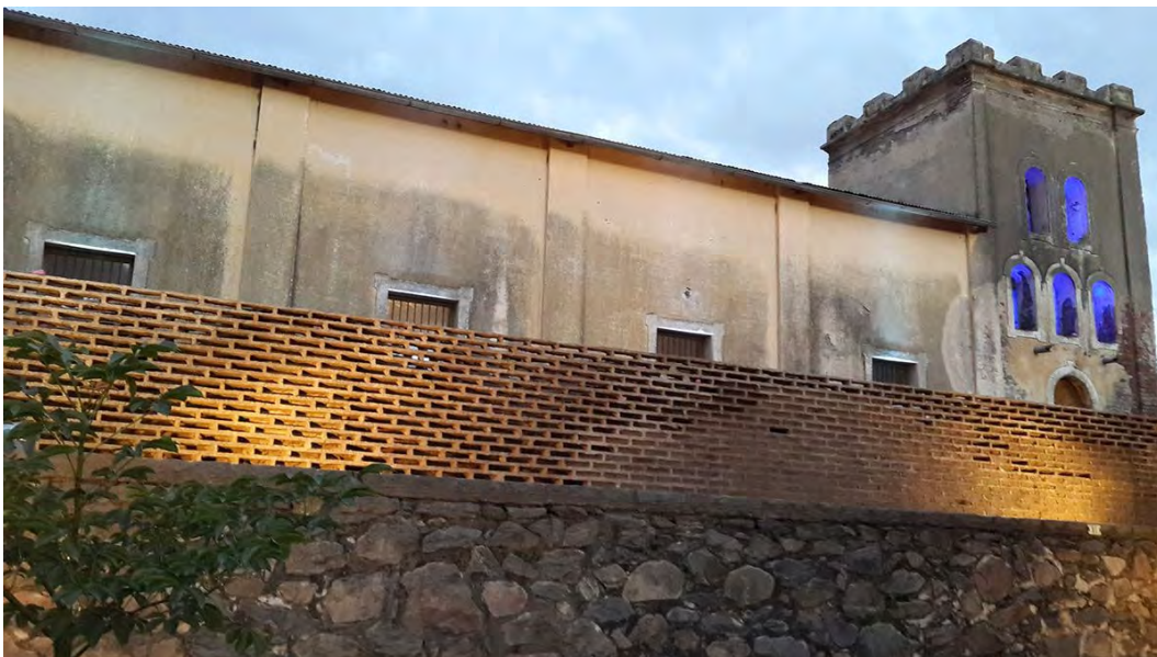
Figura 71 - Muro em seu estado último Fonte: Ricardo Sargiotti / Rovea Sargotti Arquitectura
