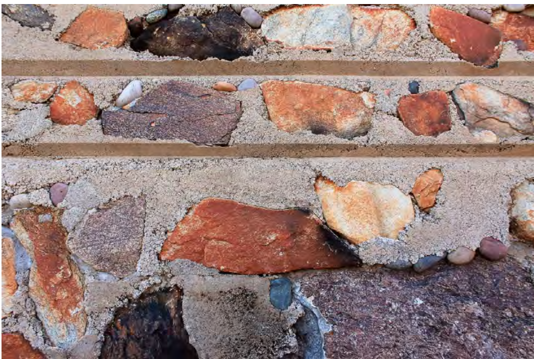
Figura 10 - Detalhe da alvenaria estrutural, composta de pedras locais do deserto do Arizona Fonte: Frank Lloyd Wright Foundation
