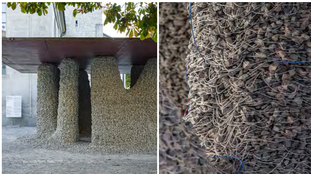
Figura 38 - Rock Print Pavilion , 2018 – Pavilhão e detalhe do método construtivo Fonte: Georg Aerni / Gramazio Kohler Research
