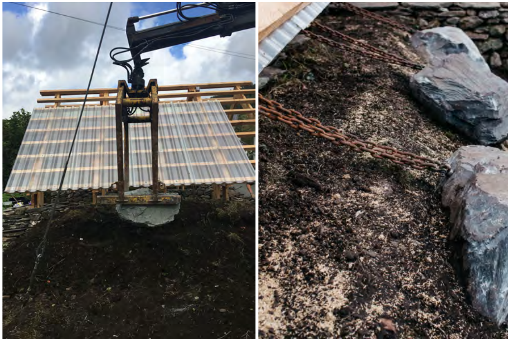
Figura 109 - Colocação das pedras fixadas por correntes ao telhado Fonte: Material Cultures
