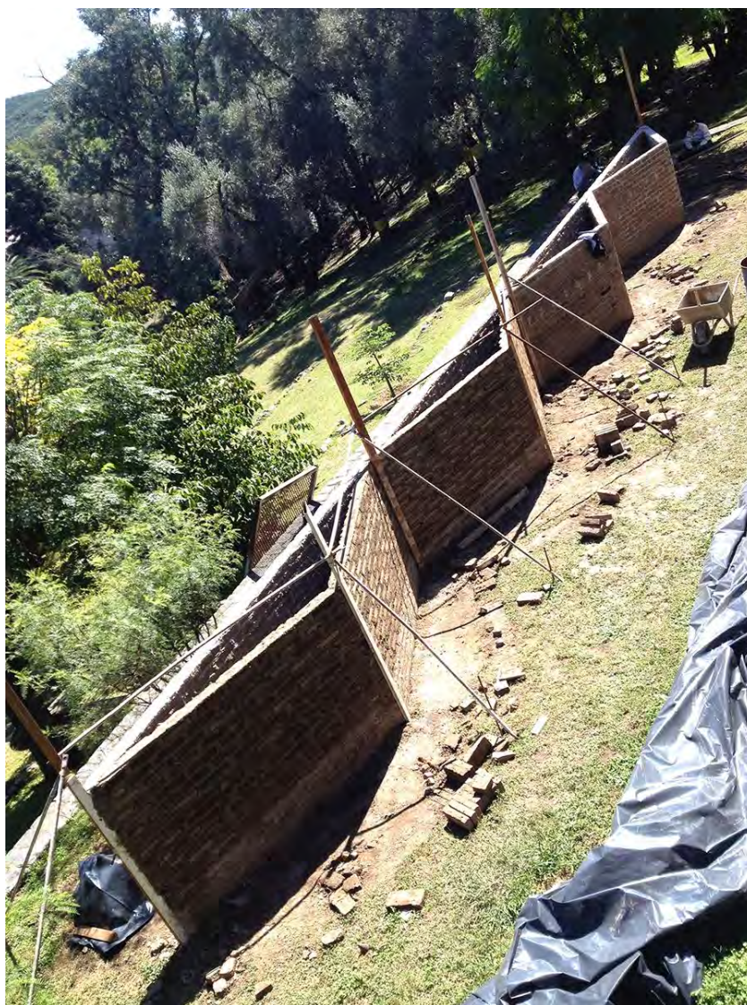
Figura 65 - Construção do muro Fonte: Ricardo Sargiotti / Rovea Sargotti Architectura
