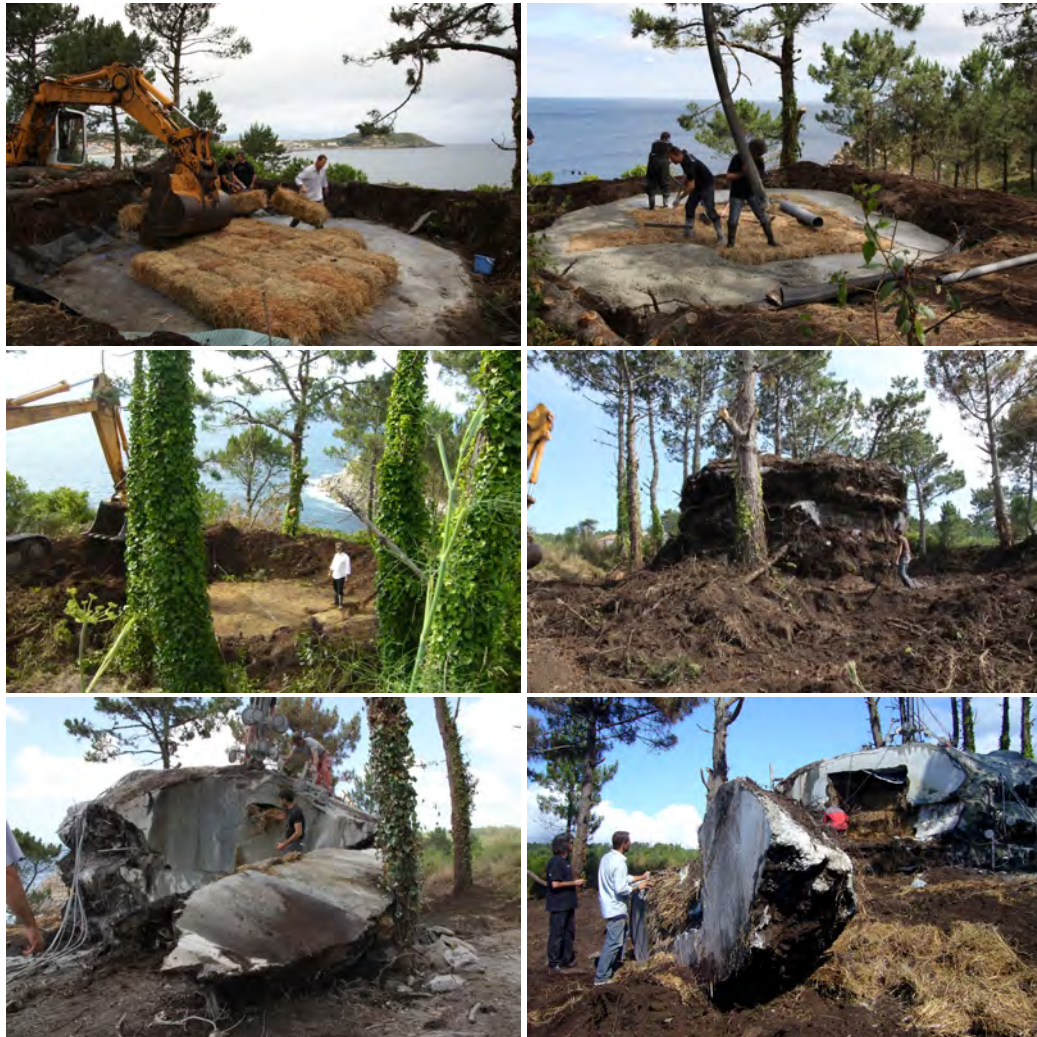
Figura 73 - Processo de construção Fonte: Ensamble Estudio / ArchDaily
