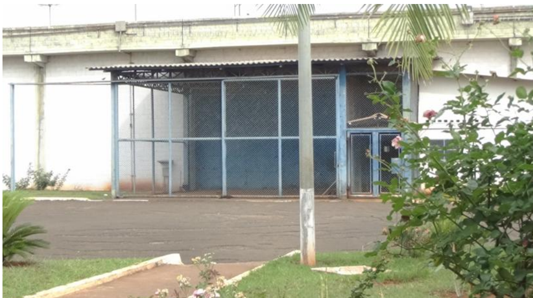
Figura 7 – Portão de entrada para a muralha
