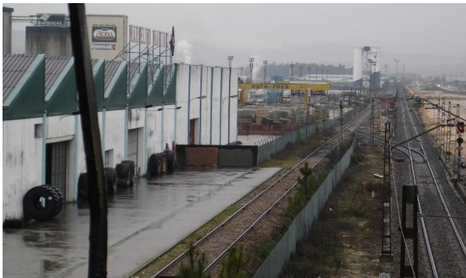
Figura 19 – Polo Industrial Das Gándaras, Porriño, Espanha: (a) Indústria de beneficiamento de granito, (b) Indústria de pré fabricados para a construção civil, que utiliza agregados provenientes do granito e (c) linha férrea para transporte dos produtos finais da mineração.
