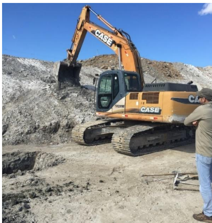
Figura 68 – Escavação para se chegar às profundidades de coleta das amostras em junho de 2016.
