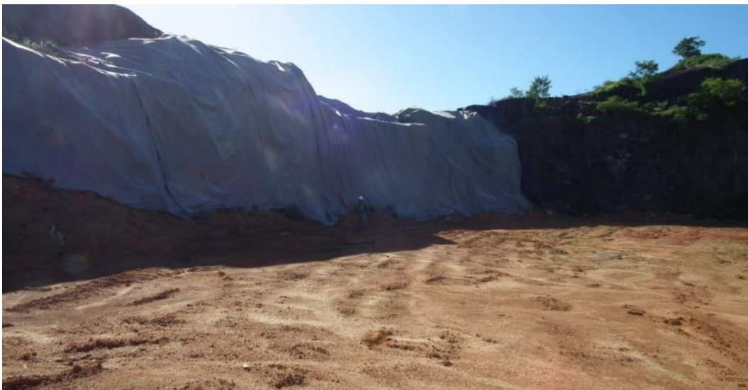
Figura 121 – Barreira mineral de fundo da célula sendo preparada e detalhe dos geotêxteis afixados em suas laterais para proteção da camada superior de geomembrana em outubro de 2013.
