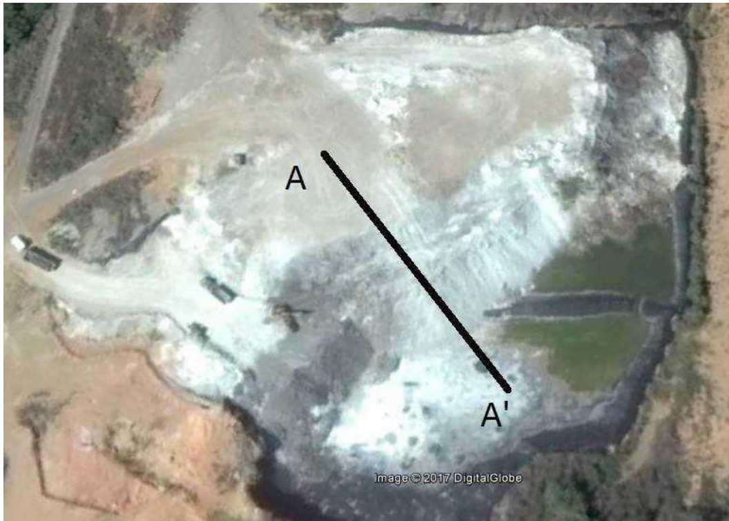
Figura 130 – Vista da seção A-A' do maciço de rejeitos no momento da coleta das amostras em junho de 2016.
