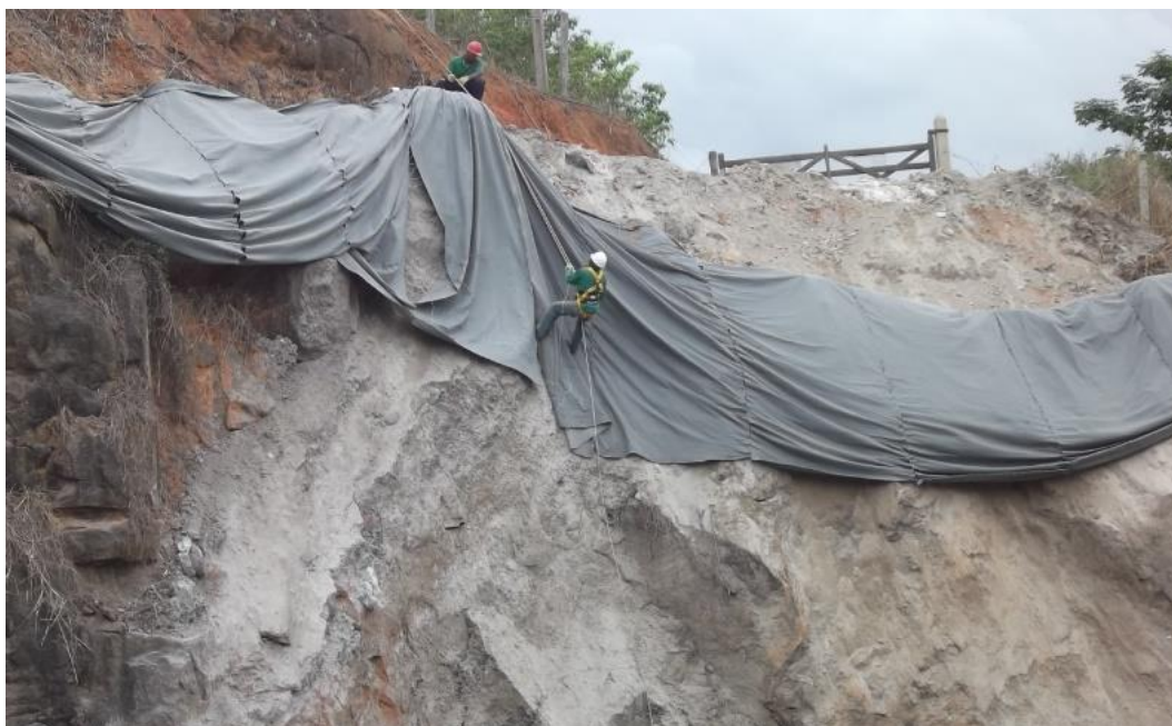
Figura 24 – Área 1 – Instalação do geotêxtil não-tecido em setembro de 2009.
