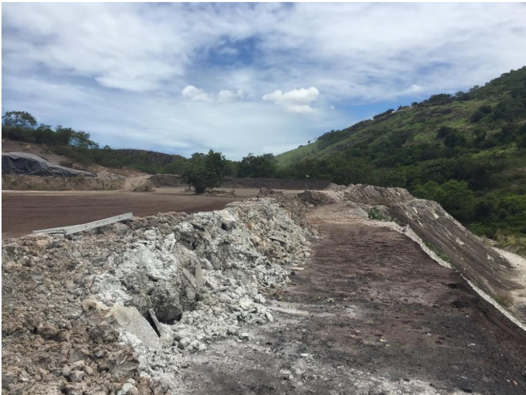
Figura 124 – Vista de taludes e bermas de estabilização do maciço de rejeitos em formação em janeiro de 2019.
