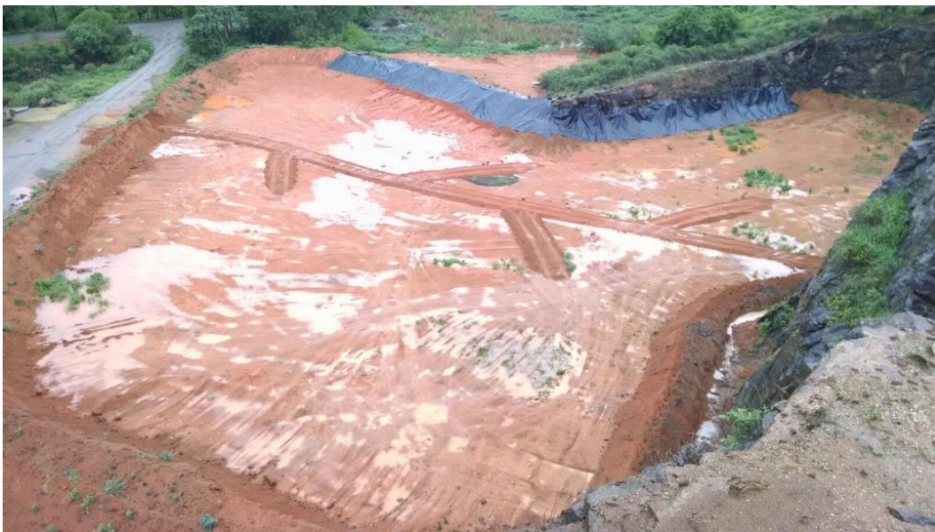
Figura 36 – Implantação do fundo da célula da Área 2 sendo finalizado em maio de 2015.
