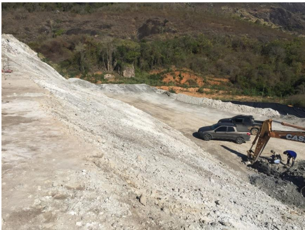
Figura 131 – Vista da seção A-A', podendo-se observar o local da coleta de amostras no platô intermediário do maciço de rejeitos.
