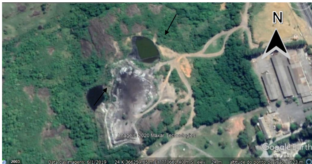
Figura 125 – Imagem superior do maciço de rejeitos em formação, com detalhe para os dois reservatórios de acúmulo das águas pluviais em janeiro de 2019. Fonte: Extraída do Google Earth em abril de 2020.
