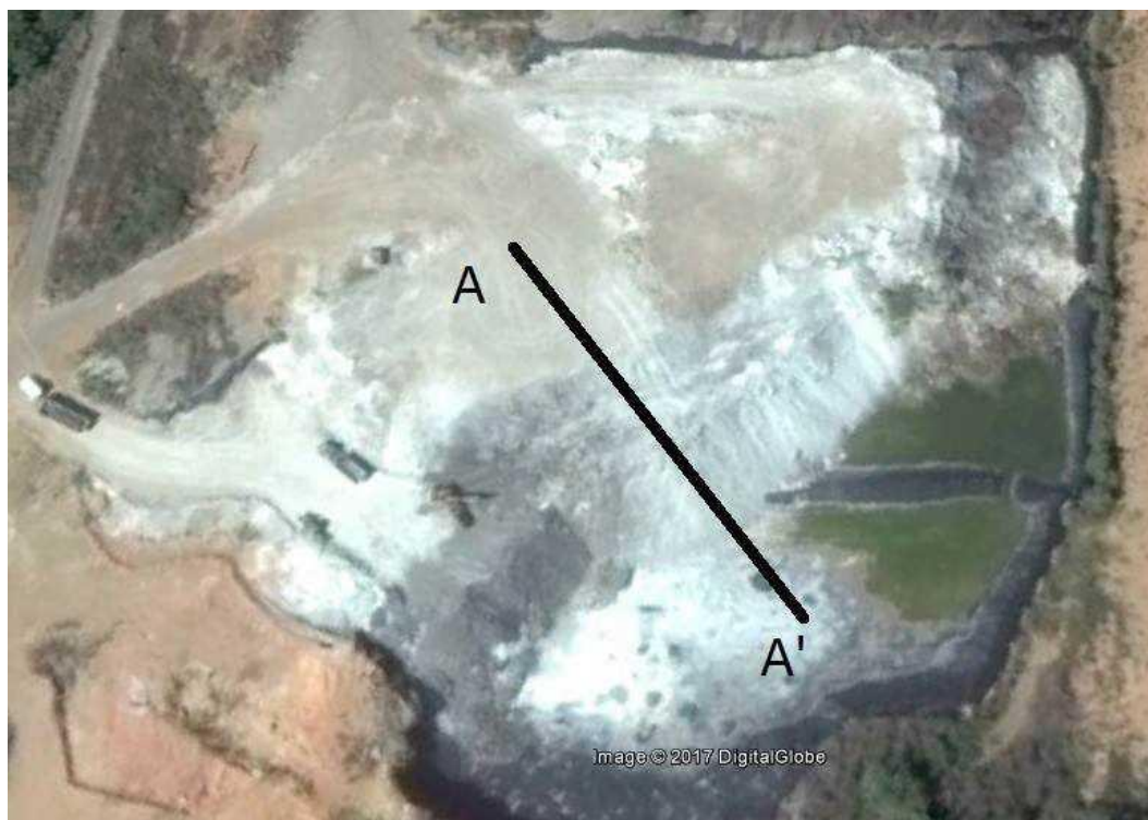
Figura 137 – Vista da seção A-A' do maciço de rejeitos no momento da coleta das amostras em junho de 2016.
