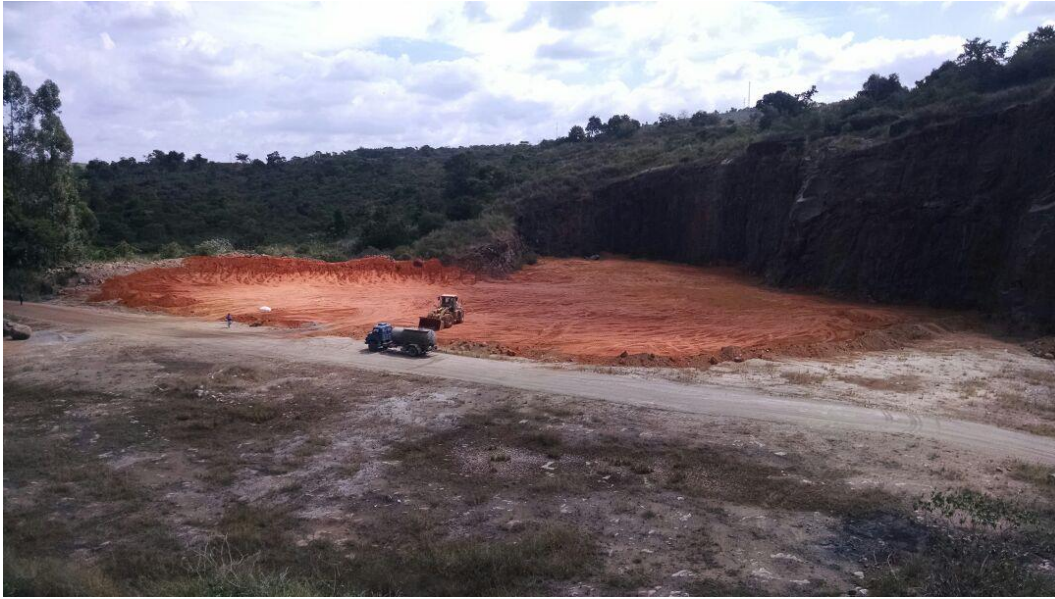
Figura 35 – Início das obras de implantação da barreira mineral do fundo da célula da Área 2 em abril de 2015.
