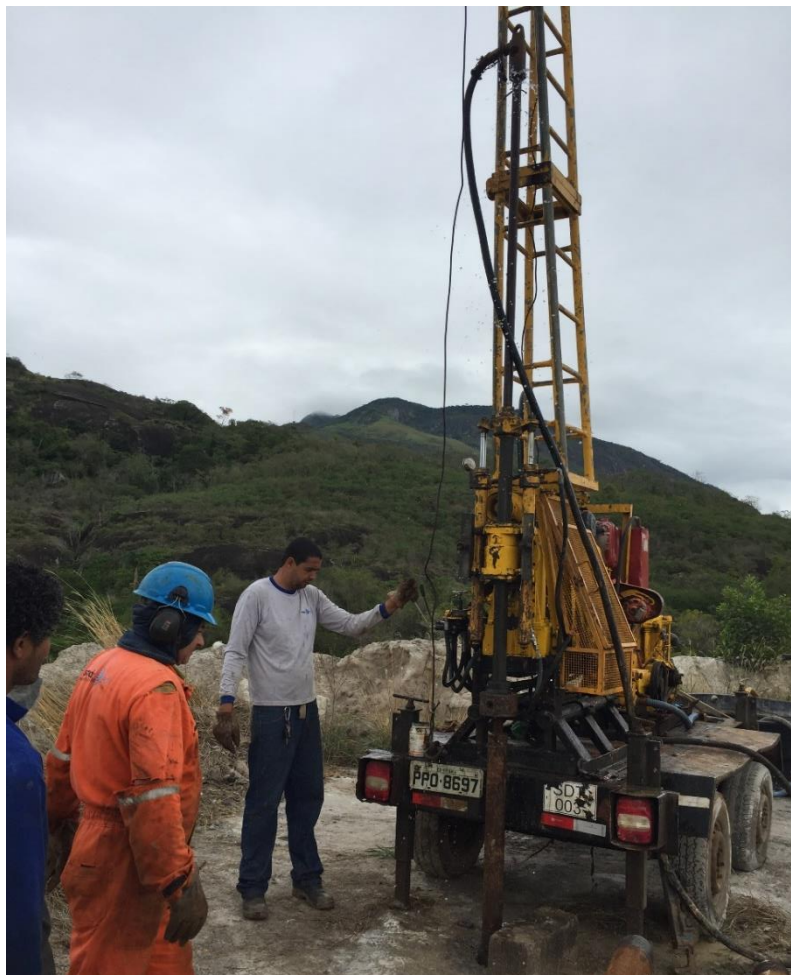
Figura 75 – Equipamento de sondagem rotativa, utilizado na instalação dos piezômetros da área monitorada.
