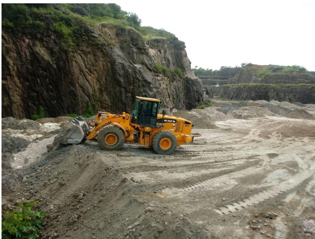
Figura 38 – Espalhamento e compactação da lama desaguada do beneficiamento de granitos na célula da Área 2 em dezembro de 2019.
