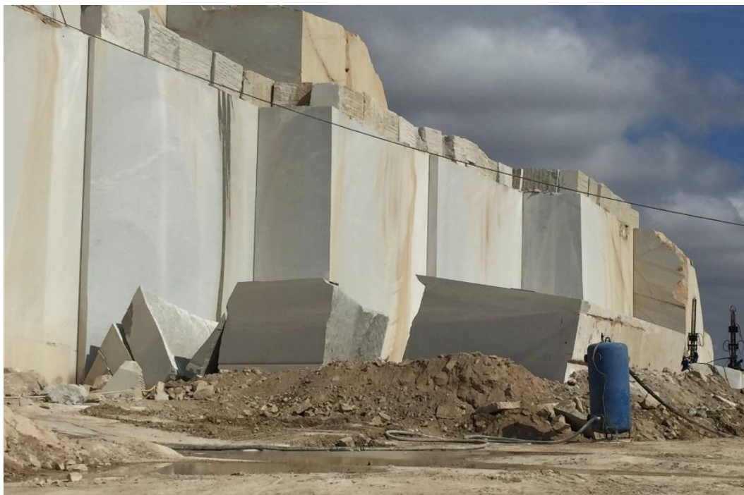
Figura 82 – Tombamento de bancada com altura múltipla, utilizando colchões de rejeitos para o amortecimento, em pedreira de granito amarelo situada no norte do ES.
