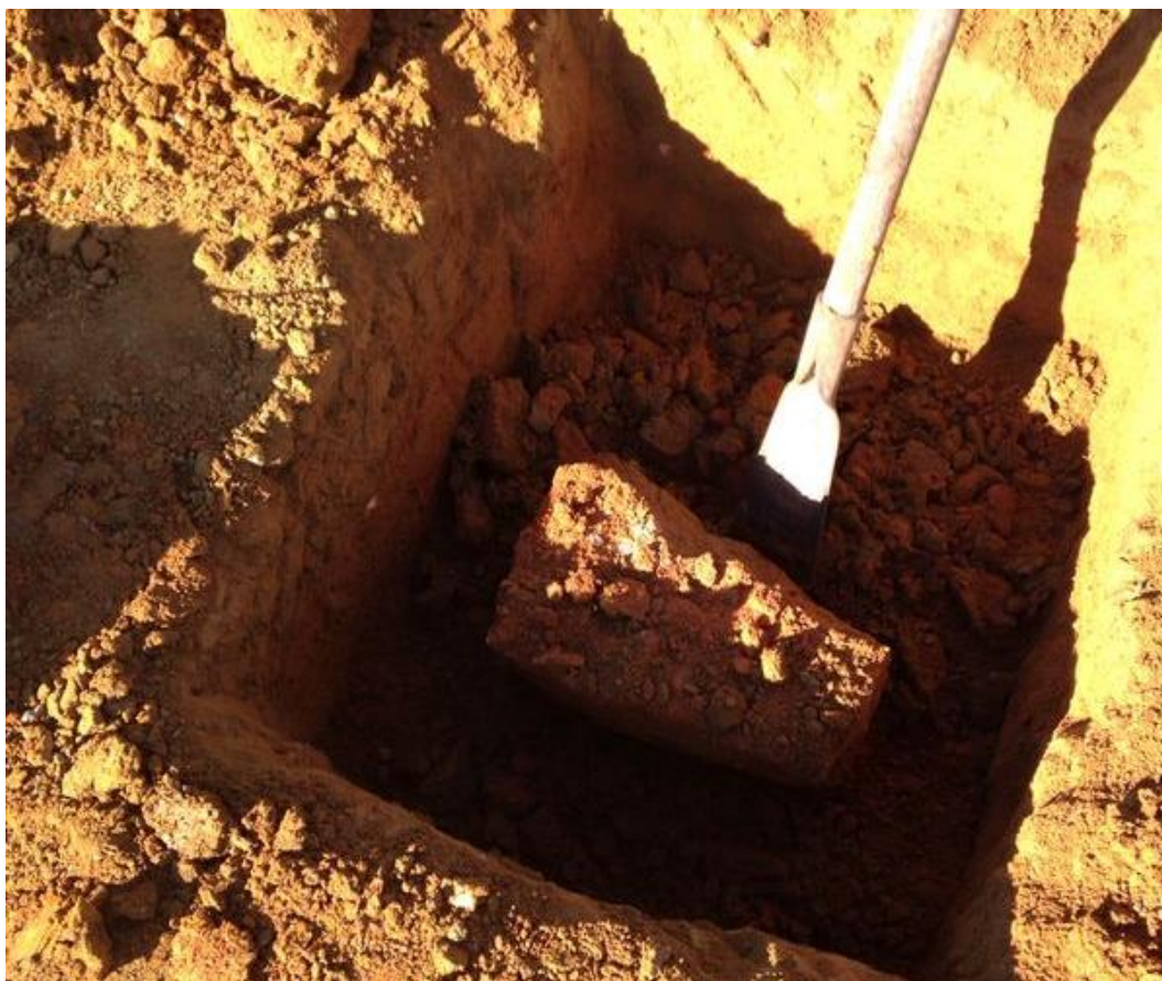
Figura 63 – Retirada do bloco da amostra indeformada da barreira mineral de fundo, após sua implantação, da célula de disposição final do aterro industrial de rejeitos de rochas ornamentais.
