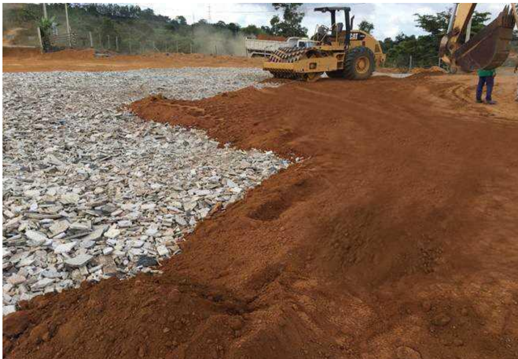
Figura 28 – Área 1 – Implantação das camadas drenante e de solo para a revegetação em fevereiro de 2016.
