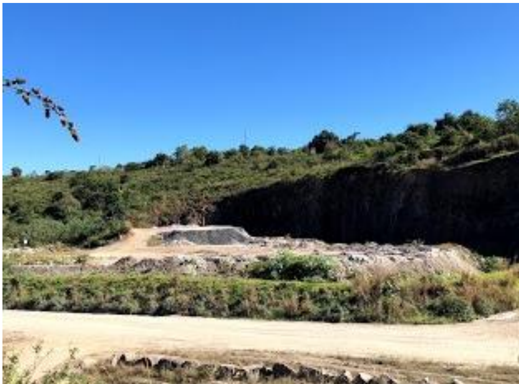
Figura 41 – Vista do maciço de rejeitos de granitos em formação na Área 2, com detalhe da vegetação crescendo naturalmente sobre as bermas de estabilização laterais, em julho de 2020.
