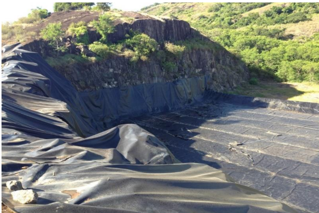
Figura 122 – Impermeabilização com geomembrana de PEAD do fundo e das laterais de parte da célula em construção em fevereiro de 2014.
