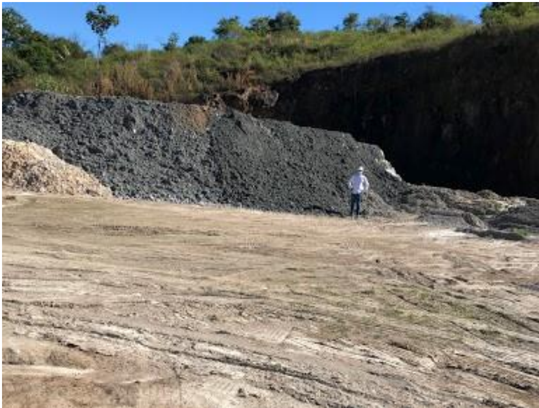
Figura 39 – Formação de novo platô para a disposição da lama desaguada do beneficiamento de granitos na célula da Área 2 em julho de 2020.
