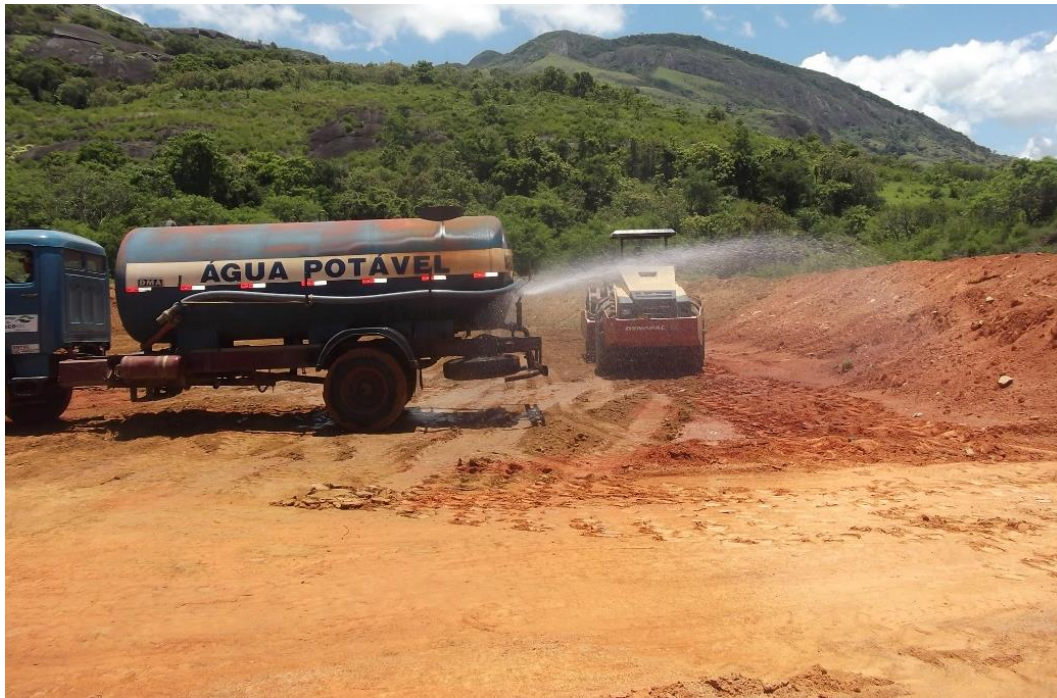
Figura 61 – Implantação da barreira mineral de fundo da célula de disposição final do aterro de rejeitos de rochas ornamentais.
