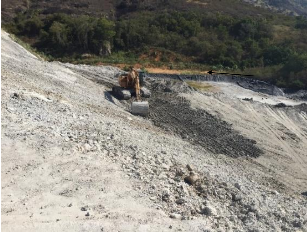
Figura 123 – Execução dos taludes e bermas de estabilização do maciço de rejeitos em formação e vista do reservatório de águas pluviais em junho de 2016.
