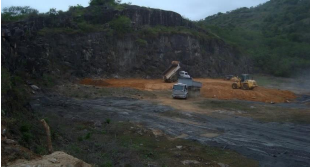
Figura 120 – Área monitorada no início das obras de implantação da célula de disposição de rejeitos de rochas ornamentais em setembro de 2013.
