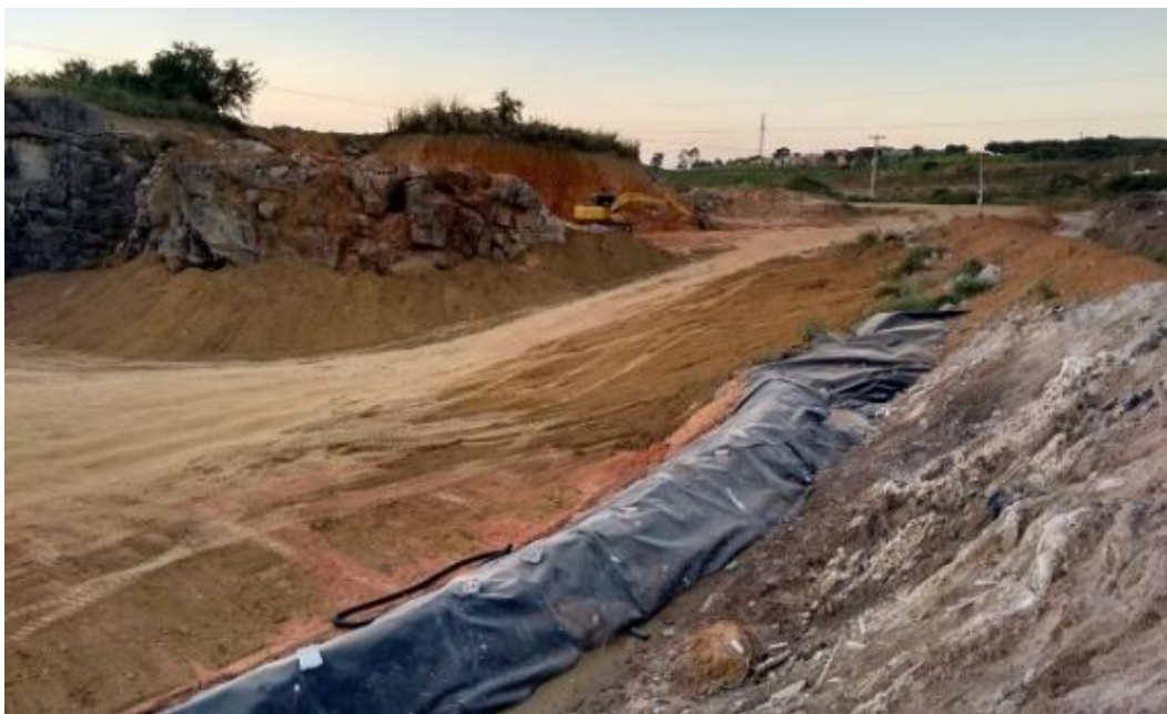
Figura 60 – Jazida de exploração do solo utilizado para implantação da barreira mineral de fundo da célula de disposição final do aterro de rejeitos de rochas ornamentais.
