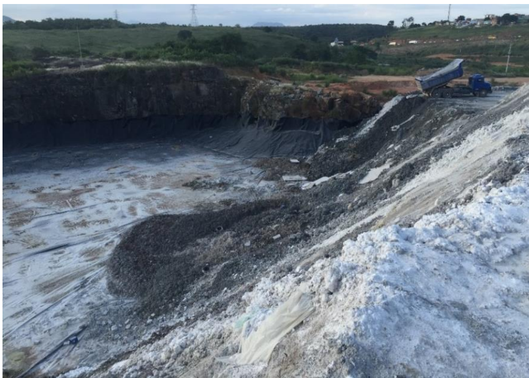
Figura 58 – Célula de disposição final de rejeitos de rochas ornamentais, local da coletada da amostra de lama de beneficiamento pesquisada.
