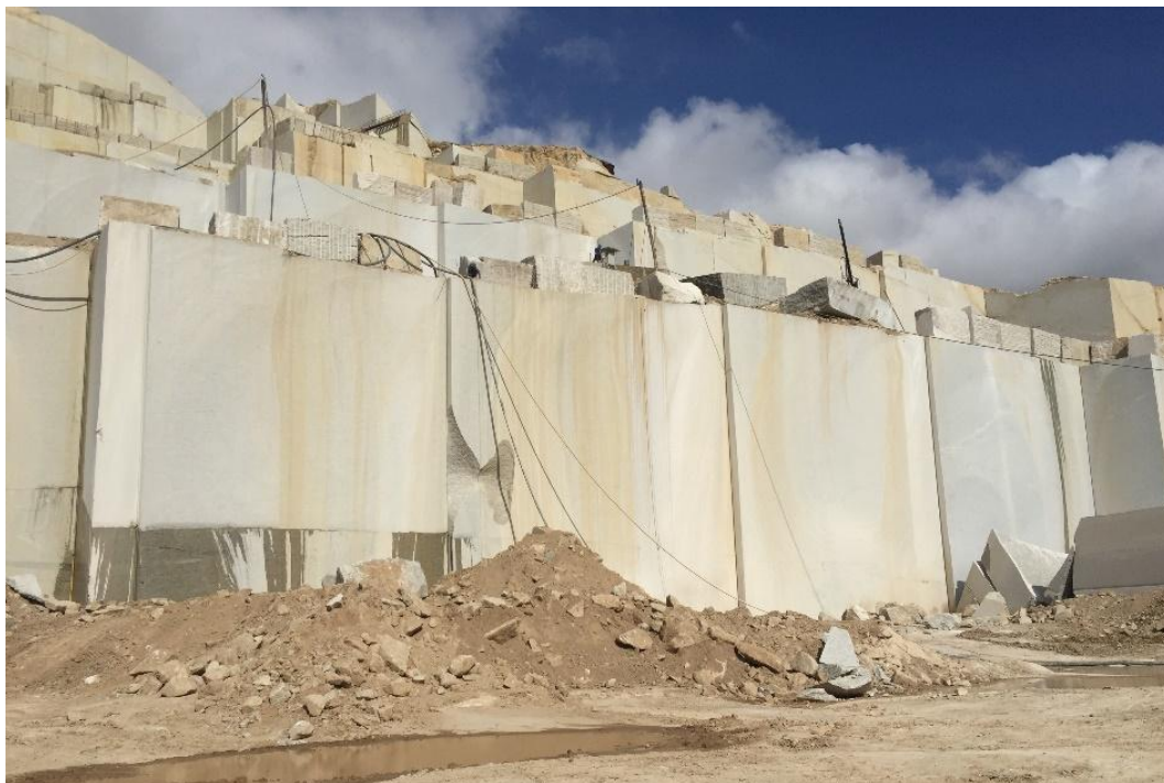
Figura 80 – Corte de bancada com altura múltipla em pedreira de granito amarelo situada no norte do ES.
