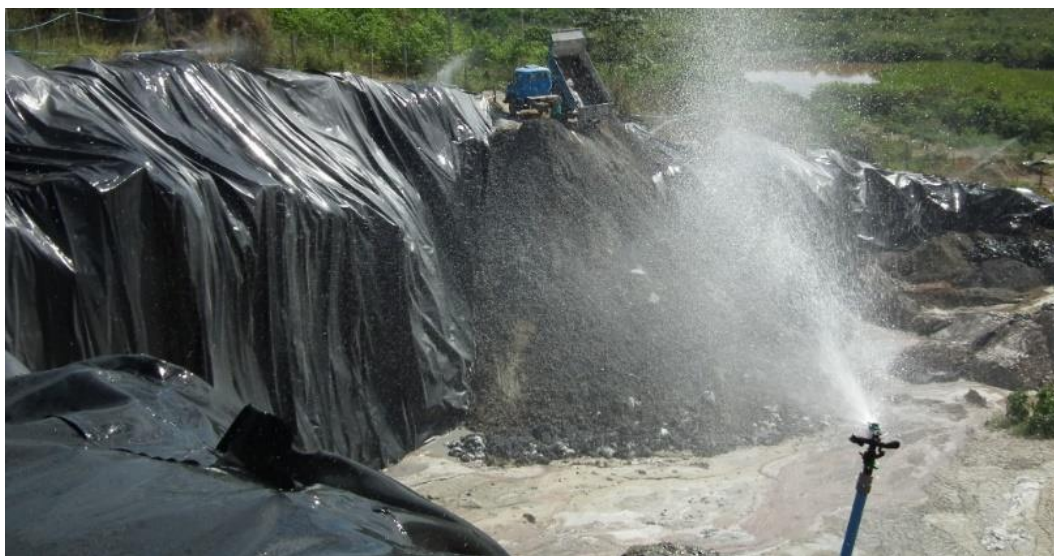
Figura 25 – Área 1. Detalhes das paredes laterais da célula impermeabilizada com geomembrana, da aspersão (reuso) das águas pluviais e do descarregamento de rejeitos em dezembro de 2011.
