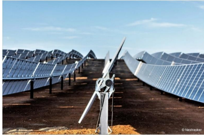
Figura 4 – Ilustração da instalação de módulos em estruturas rastreadoras (Vallourec).
