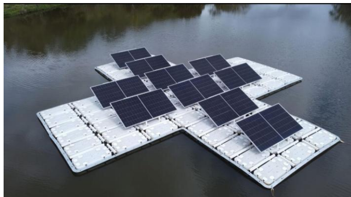
Figura 5 – Ilustração da instalação de módulos em estruturas rastreadoras flutuantes (CPG, 2024)
