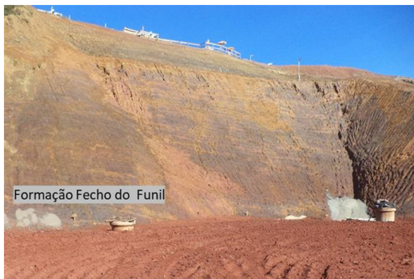
Figura 3.1 – Filito da formação Fecho do Funil aflorando na ombreira da barragem com baixo ângulo de mergulho ( \sim 30^\circ ) para NW.
