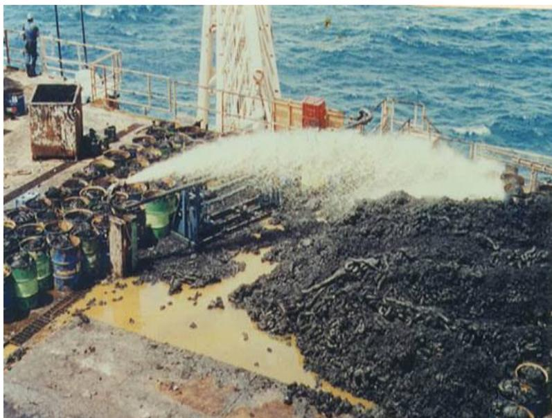
Figura 8 – Operação de remoção de parafina na Plataforma PXA-3
