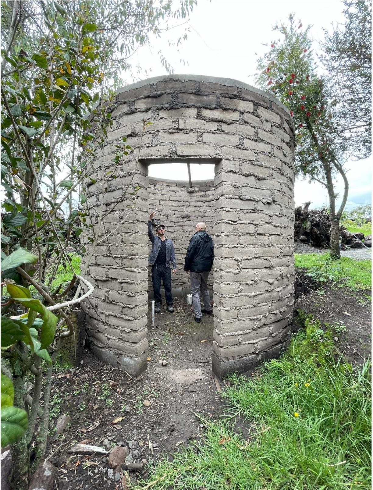
*Imagem 55 - Esteban Benavides explica para José María o sistema de cobertura que será instalado no banheiro do Cementerio Buena Muerte. Construído em adobe com terra retirada do terreno. Quito, 2024. Foto do autor.*
