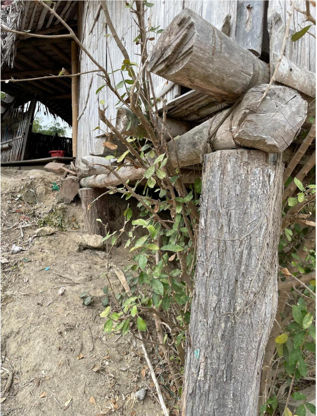
*Imagem 68 - Escuela Nueva Esperanza Dos, detalhe de transição entre as fundações de troncos rígidos cravados no solo para troncos macios que estruturam a edificação acima do solo. Foto do autor, 2024*
