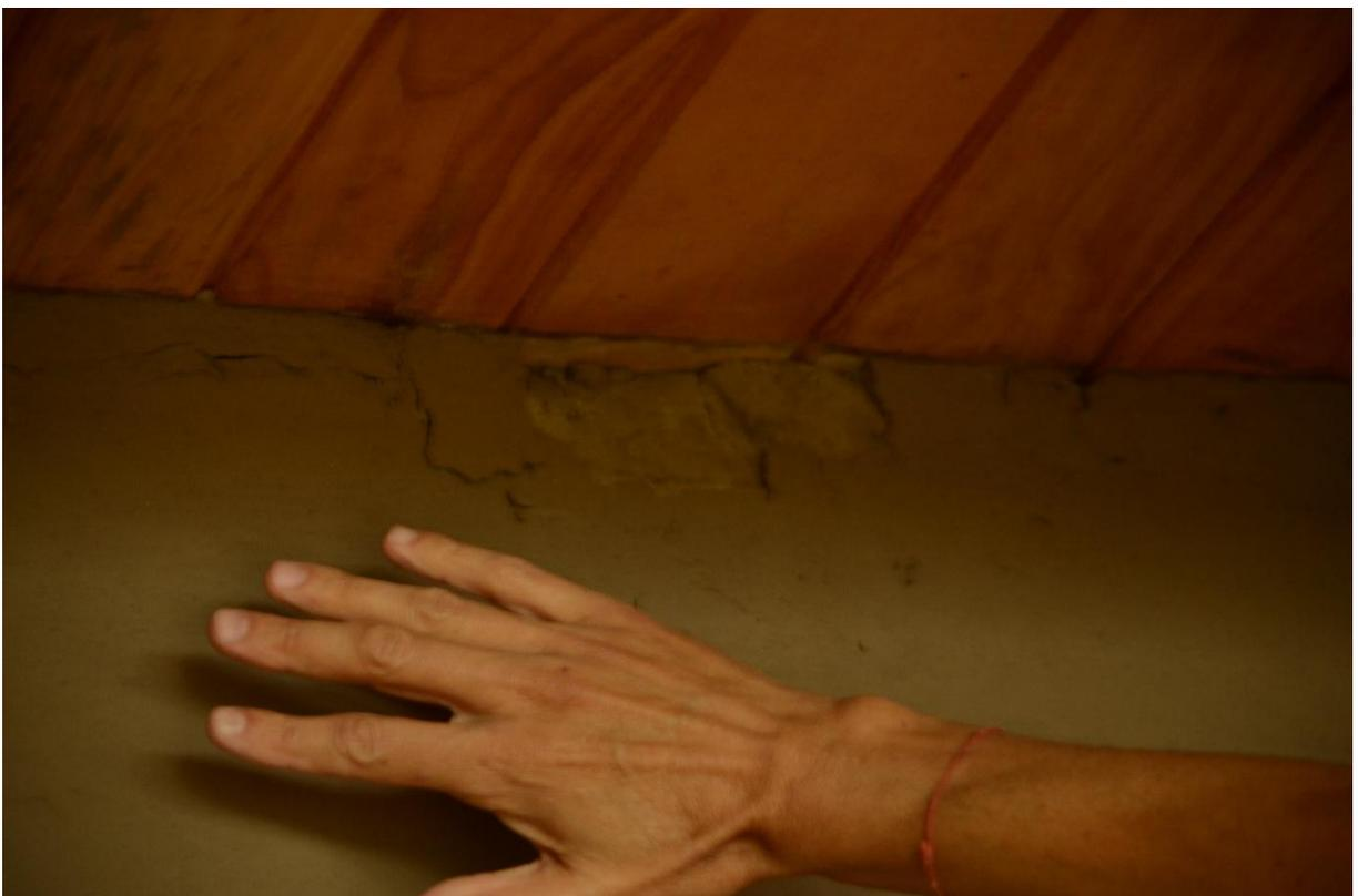
*Imagem 34 - Detalhe de um deslocamento da resina de impermeabilização do adobe encontrado na parede Oeste, aos fundos do terreno, da Casa Jardín. Quito, 2024. Foto do ator.*
