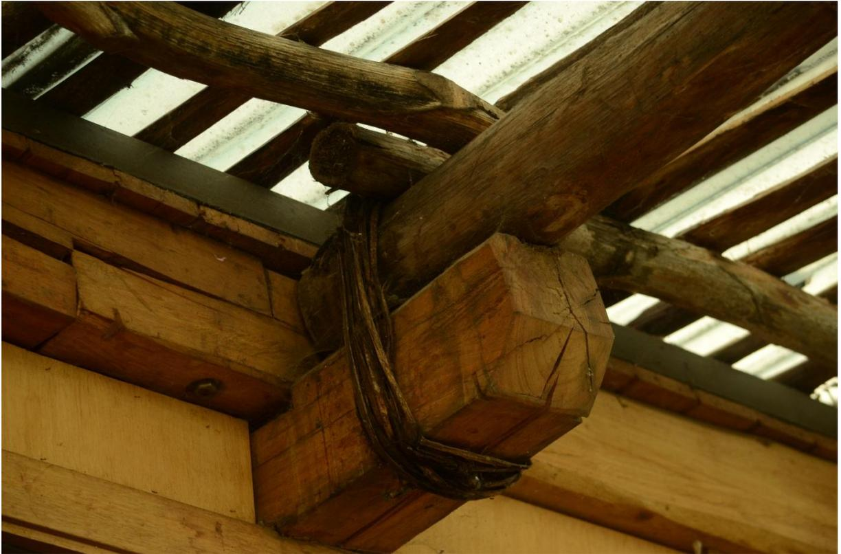
*Imagem 33 - Detalhe do encontro entre o madeiramento do telhado de vidro da varanda com a estrutura da cobertura da Casa Jardín, unidos por uma corda tensionada. Quito, 2024. Foto do autor.*
