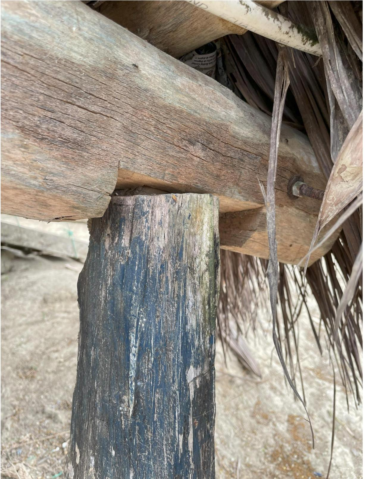
*Imagem 64 - Detalhe do encontro entre um pilar enterrado e uma viga da Escuela Nueva Esperanza. Puerto Cabuyal, 2024. Foto do autor*
