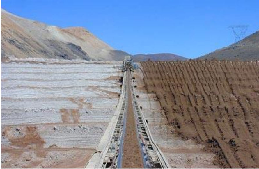
Figura 2.11 Pilha de rejeito filtrado pertencente a Conveyor, La Coipa, Chile (Guimarães, 2011)
