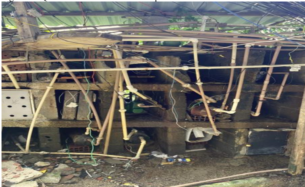
Figura 28: Quadro de bombas hidráulicas que abastecem a comunidade.
