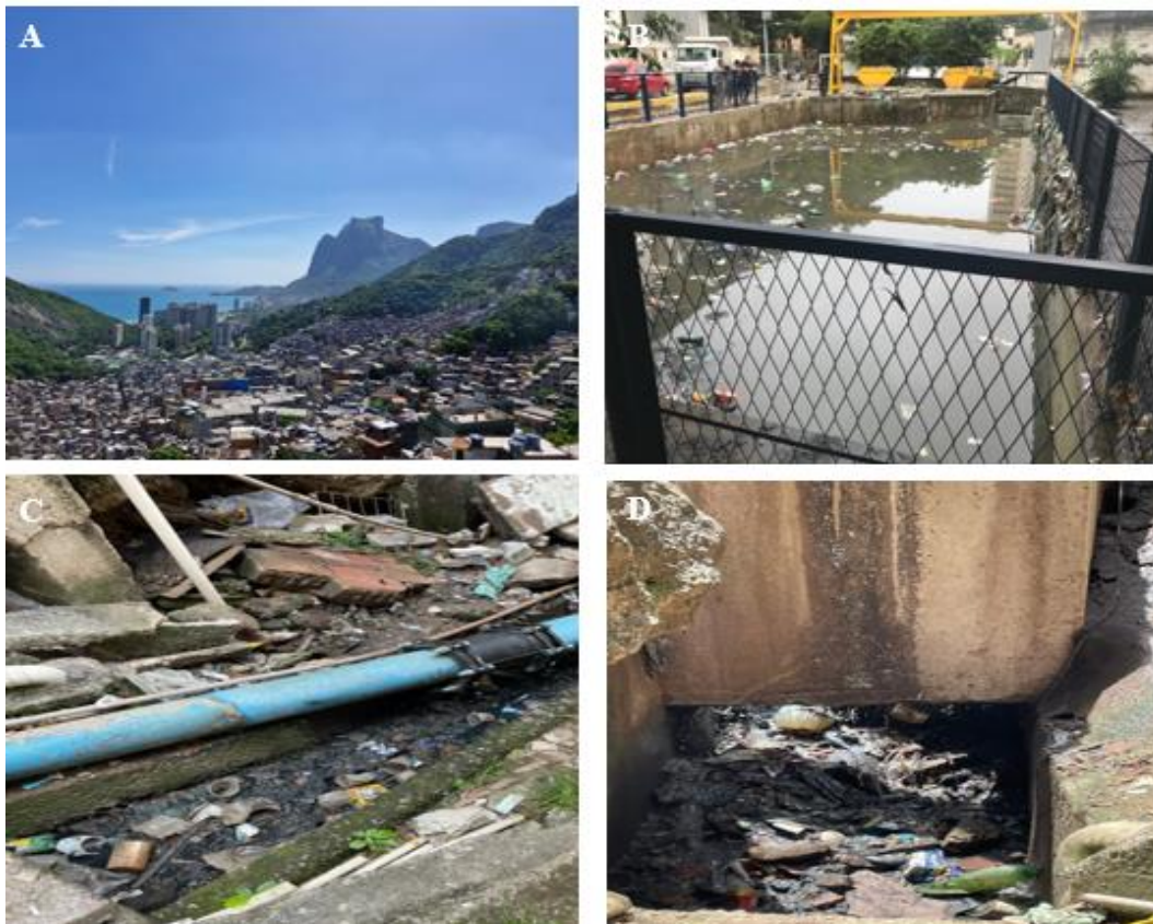
Figura 33: Realidade do Saneamento na Rocinha. (A) Vista da comunidade, destacando a ocupação urbana e a complexidade topográfica; (B) Canal de drenagem repleto de resíduos; (C) Canal de águas residuárias e presença de tubulação de água potável além de entulhos; (D) Visão do interior de uma caixa-ralo, revelando a poluição e o acúmulo de resíduos.
