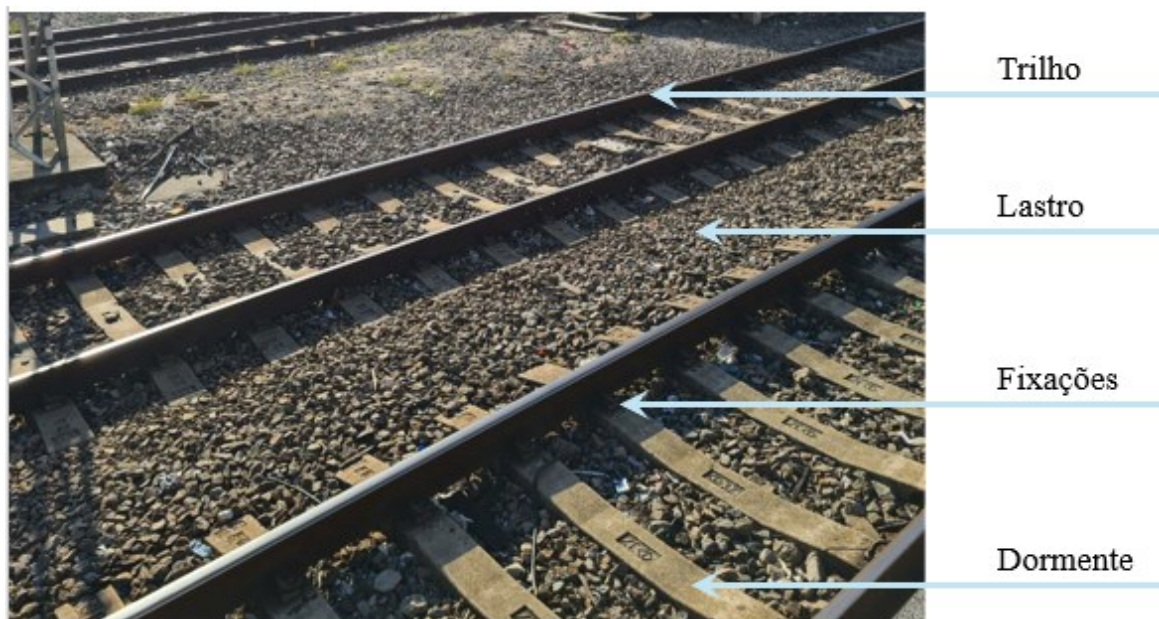
Figura 3: Via permanente da Estação Madureira, SuperVia, registrada em junho/2024.
