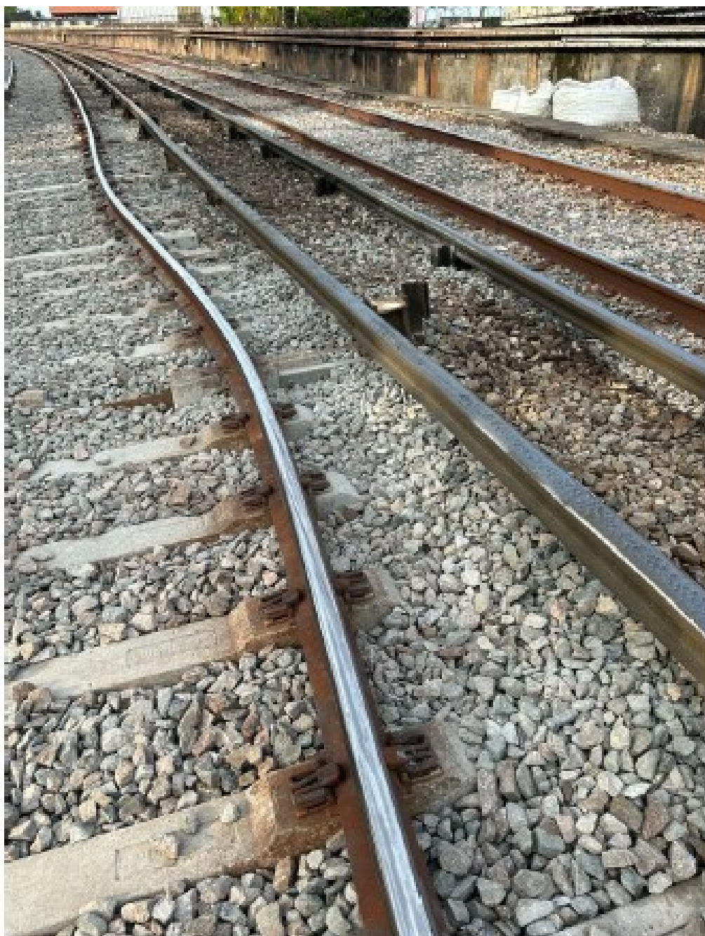
Figura 17: Via ensarilhada em dezembro de 2023, sistema metroviário.
