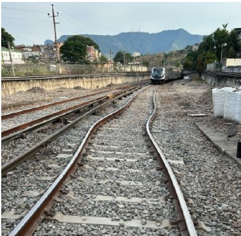
Figura 16: Via ensarilhada em dezembro de 2023, sistema metroviário.
