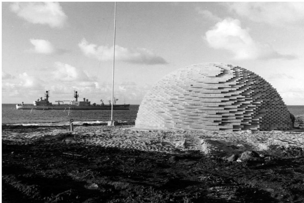
Figura 8: Carga explosiva de TNT na ilha de Kaho'olawe, Havaí, fevereiro de 1965. Cerca de 5 metros de altura e 10 de diâmetro (United States. U.S. Navy)
