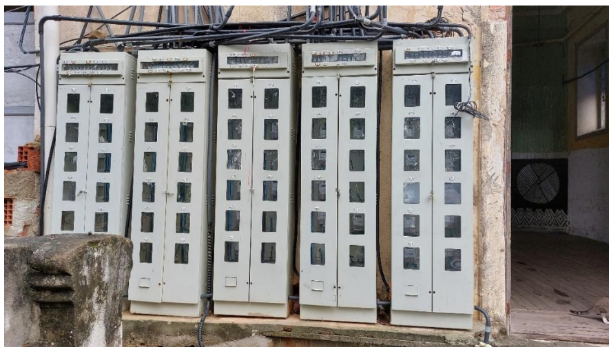
Figura 25: Parte da reforma elétrica com a aquisição de um quadro com relógios de luz. Fonte: Disciplina ARQ1325 e ARQ2019. 2024.
