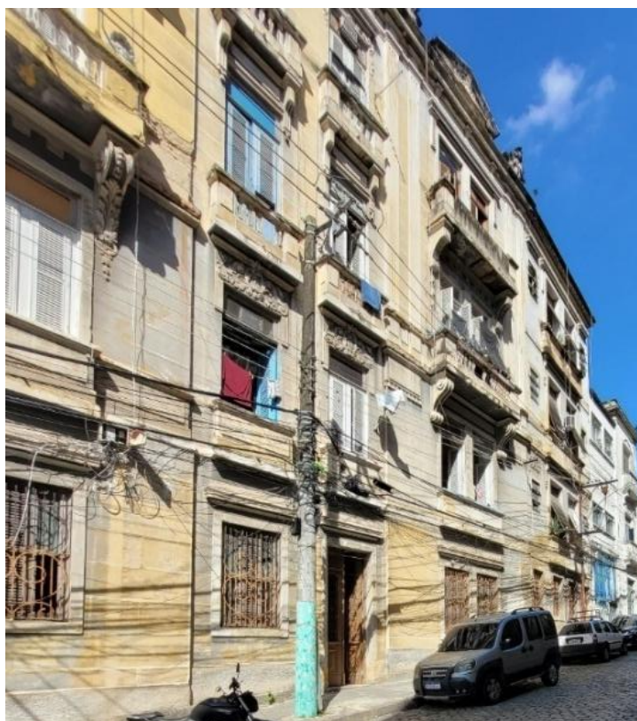
Figura 19: Fachada principal do Casarão do Hotel Moderno. Fonte: acervo próprio. 2023.
