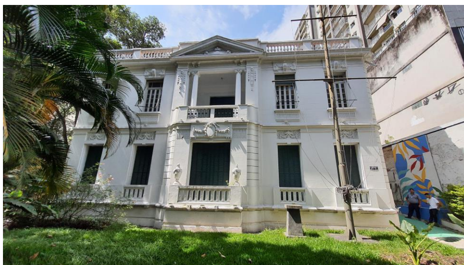
Figura 4.1 – Fachada frontal do Palacete
