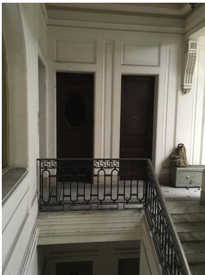
Figura 5.14 – Guardacorpo da escada em metal, esquadrias de madeira e elevador (porta da esquerda), todos elementos originais da edificação.
