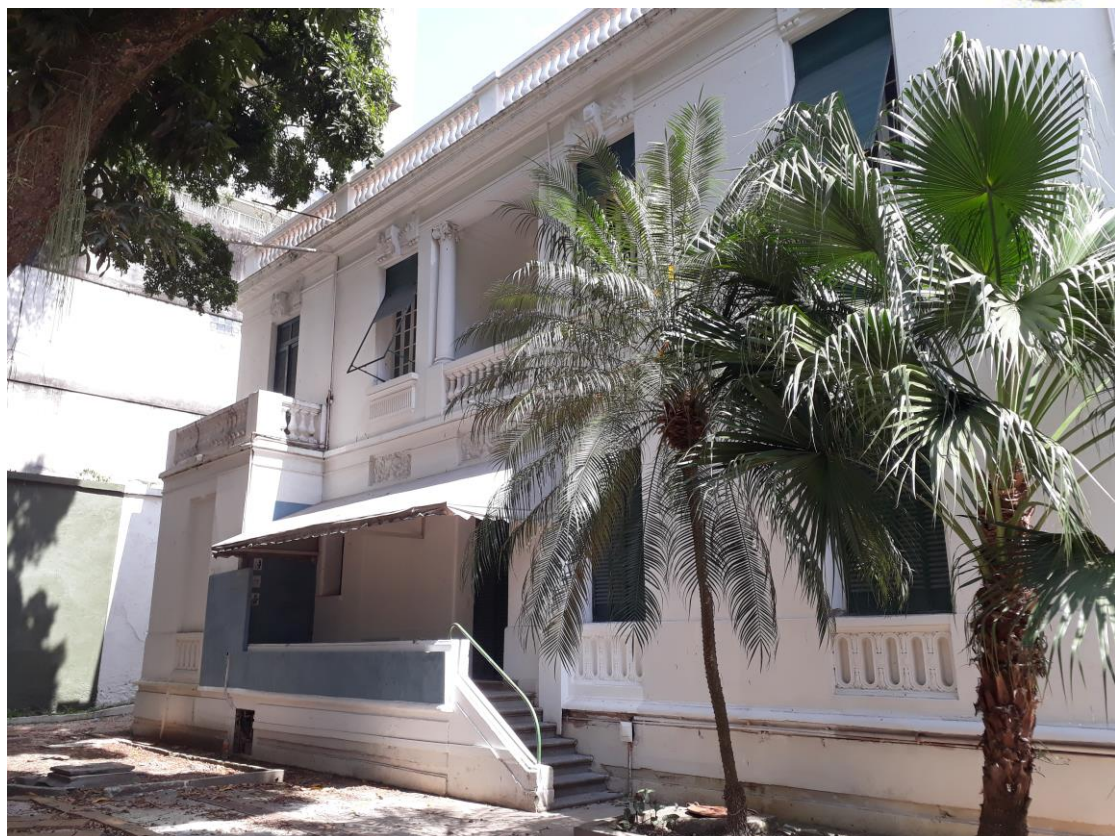
Figura 6.9 – Fachada posterior da edificação
