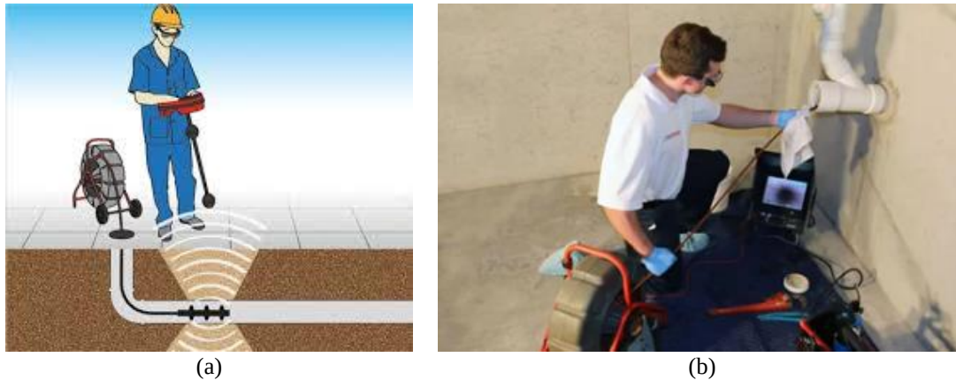
Figura 3.8 – Procedimento de vídeo inspeção. (a) ilustração do funcionamento e (b) profissional executando o ensaio.
