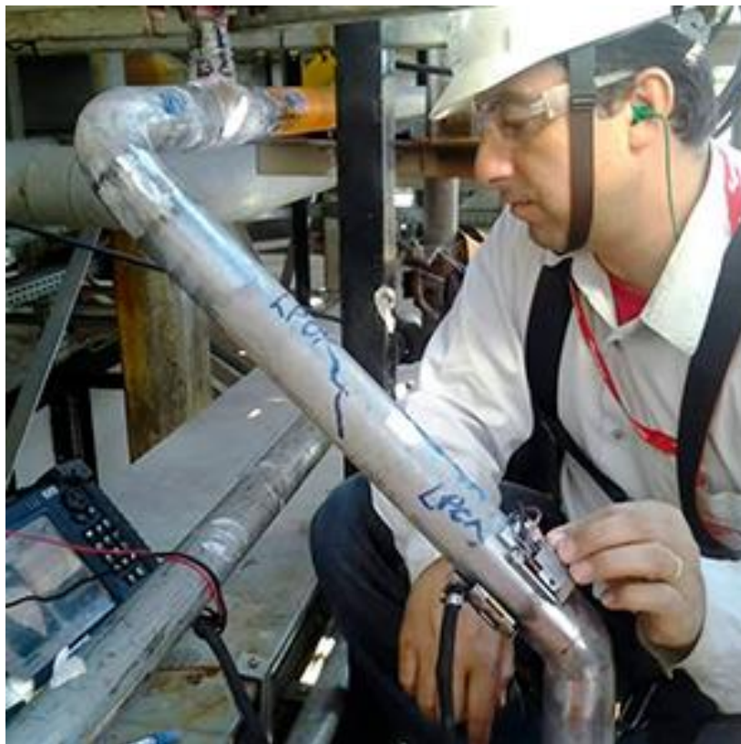
Figura 3.9 – Ultrassom em tubulações. Fonte: UTMAAX, 2022
