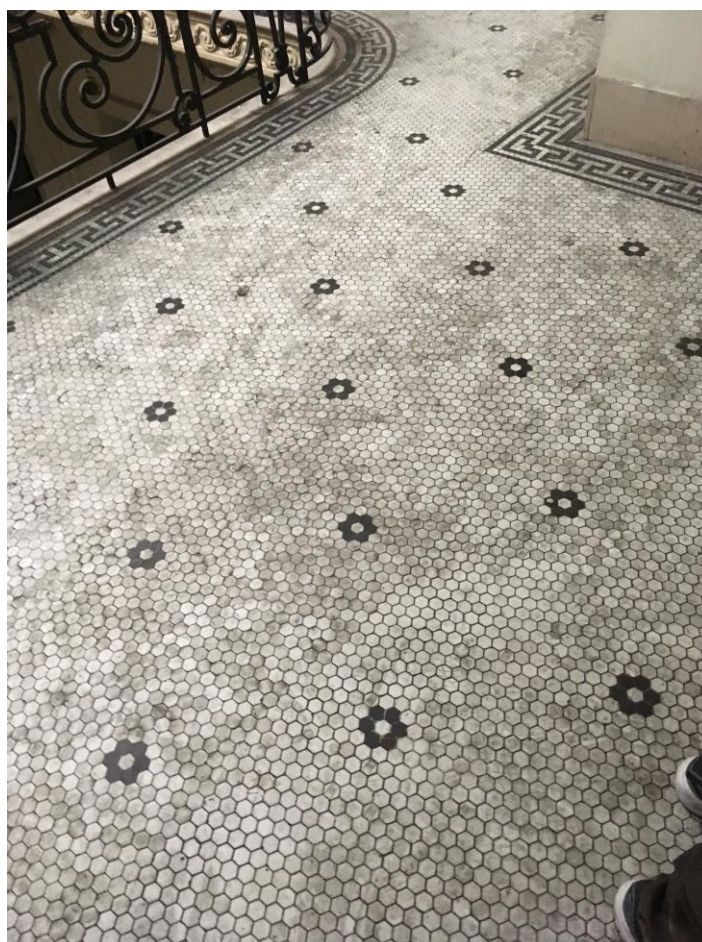
Figura 5.11 – Revestimento de piso original.
