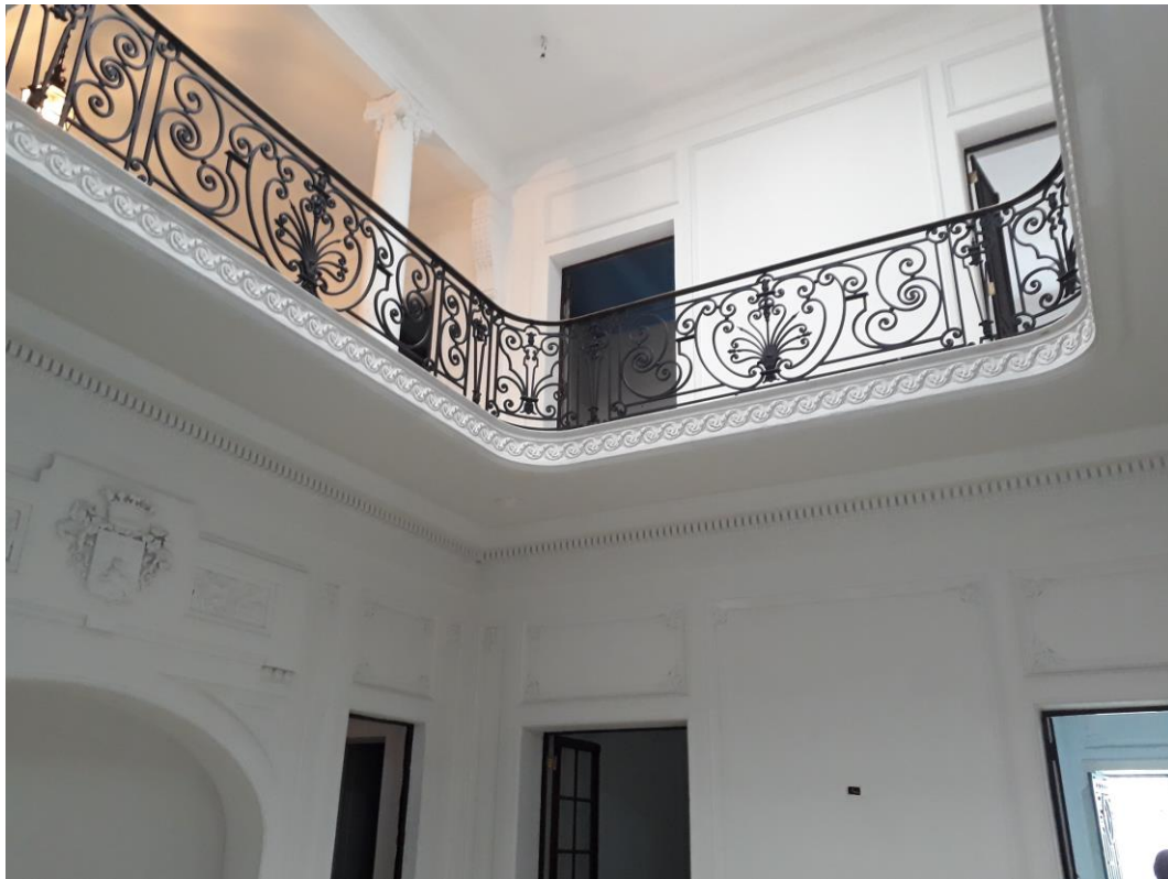
Figura 5.20 – Detalhes arquitetônicos nas paredes e guarda corpo do segundo pavimento originais da edificação.
