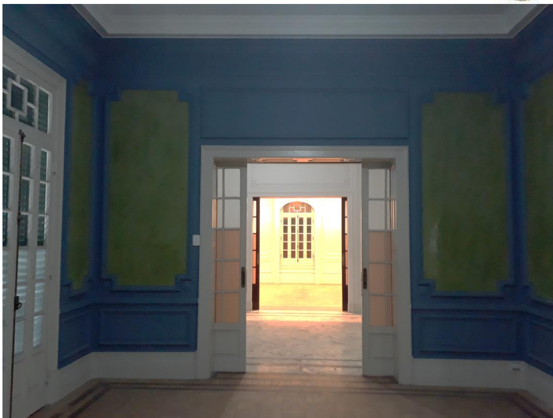
Figura 6.5 - Parede em análise a direita da fotografia, em estado de conservação similar a parede retratada.
