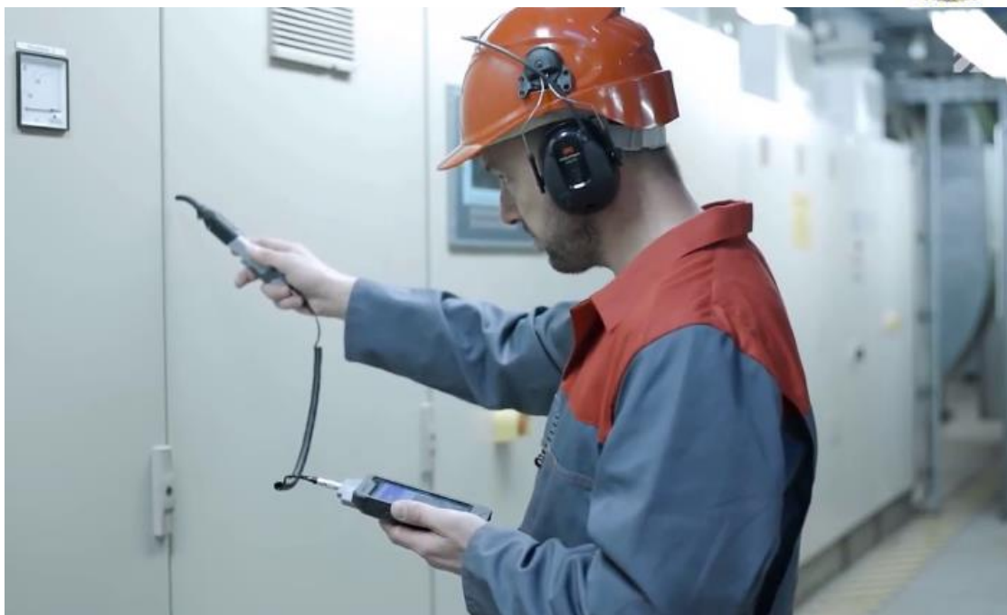
Figura 3.11 – Inspeção elétrica com ultrassom Fonte: HOTTEC, 2022
