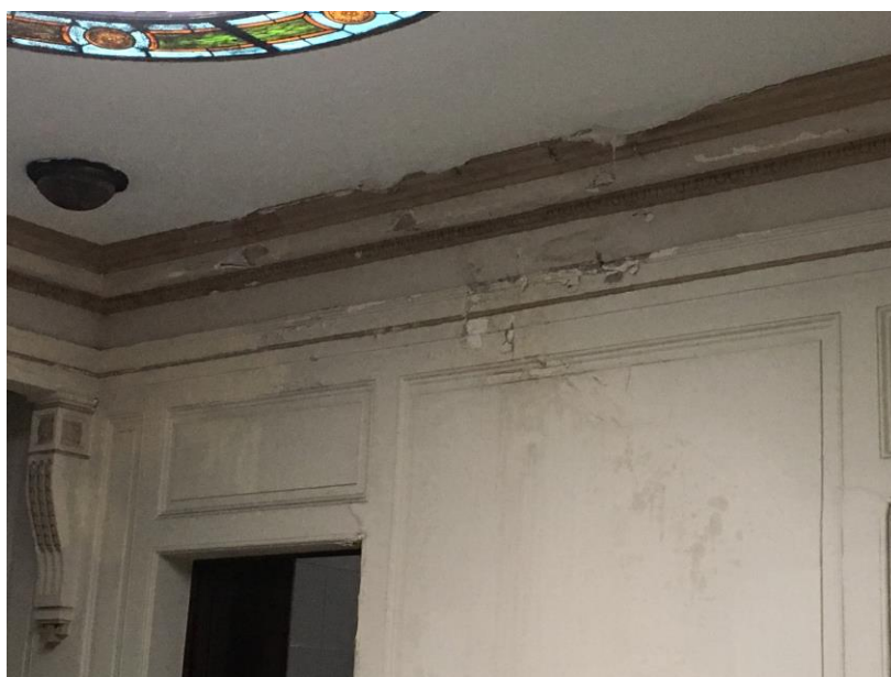
Figura 5.13 – Rodateto e detalhes do revestimento de parede, ambos elementos originais da edificação.
