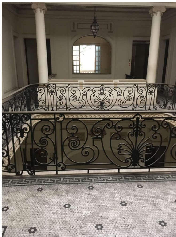
Figura 5.12 – Guarda corpo em metal e colunas ornamentais, ambos elementos originais da edificação.
