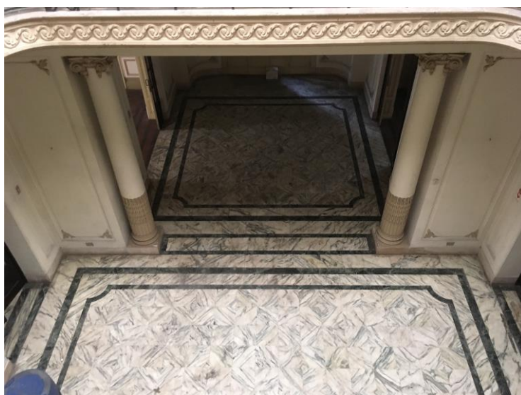
Figura 5.15 – Revestimento do piso, colunas ornamentais e detalhes no revestimento das paredes, todos elementos originais da edificação.
