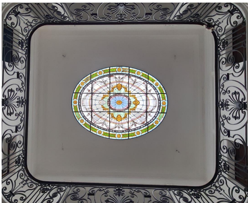
Figura 5.17 – Claraboia central em vidro ornamental, elemento original da edificação.
