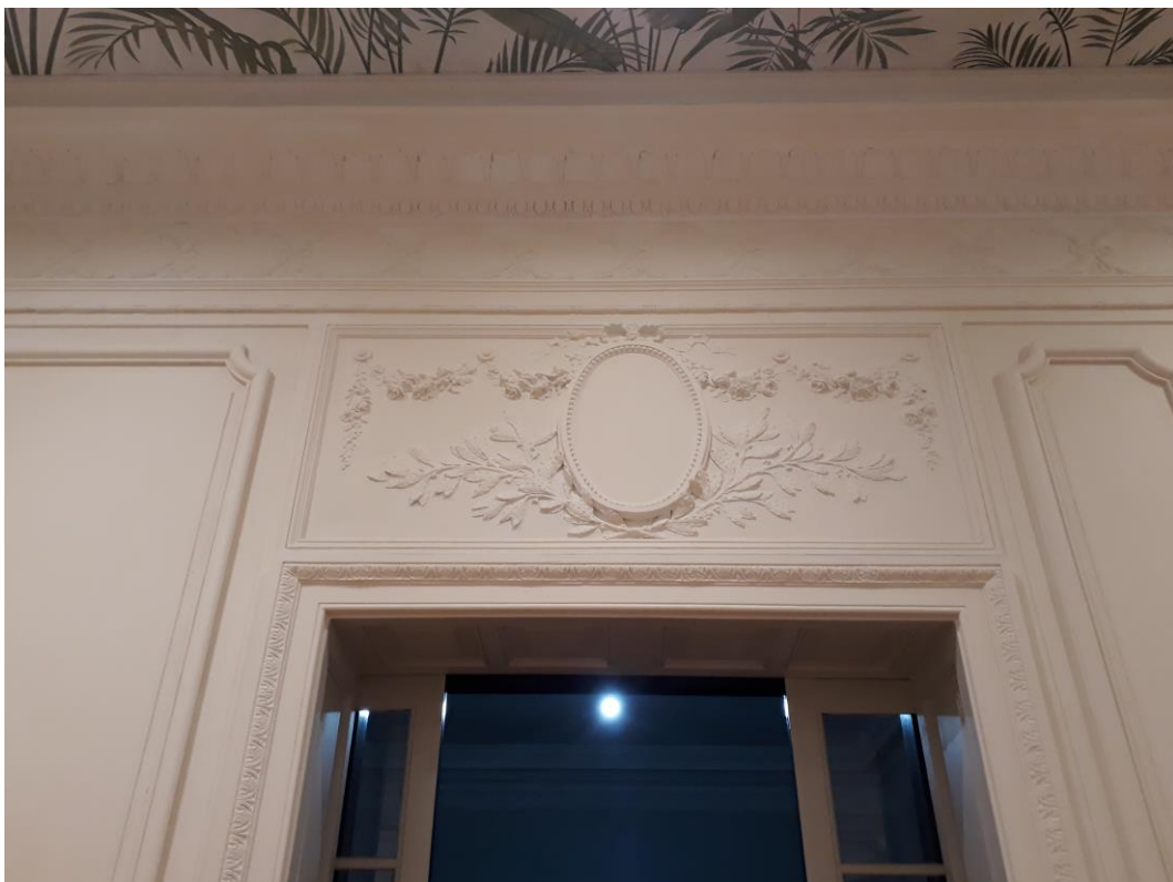
Figura 5.19 – Detalhes arquitetônicos nas paredes originais da edificação.
