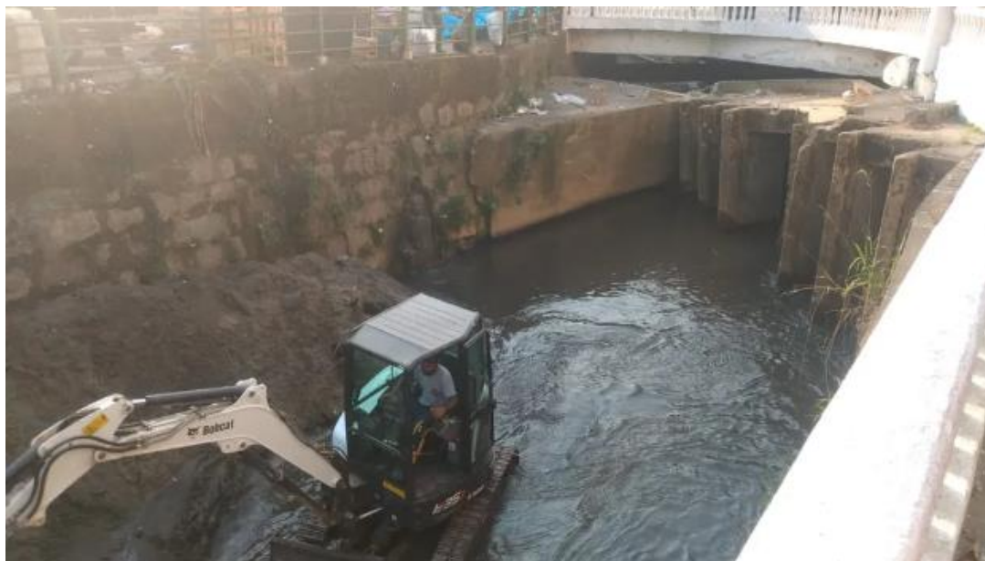
Figura 24 - Obras do túnel extravasor em Petrópolis. Fonte: Ferreira (2022)
