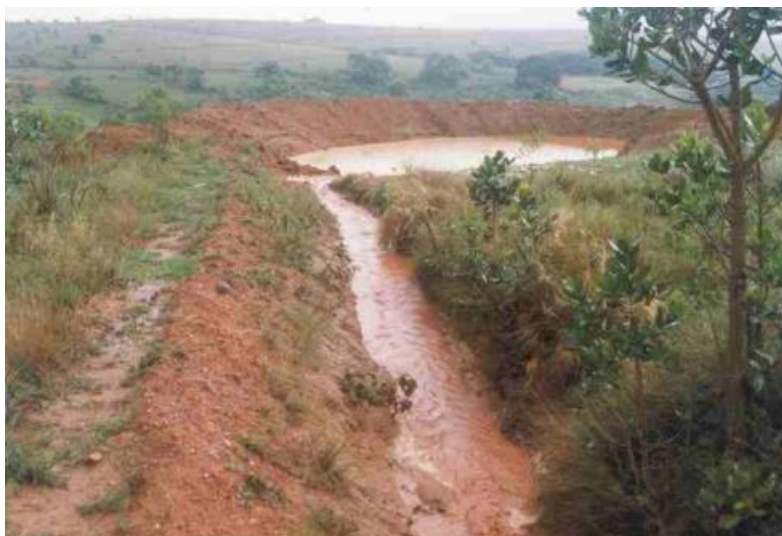
Figura 4 – Bacia de retenção. Fonte: EMATER (2006)
