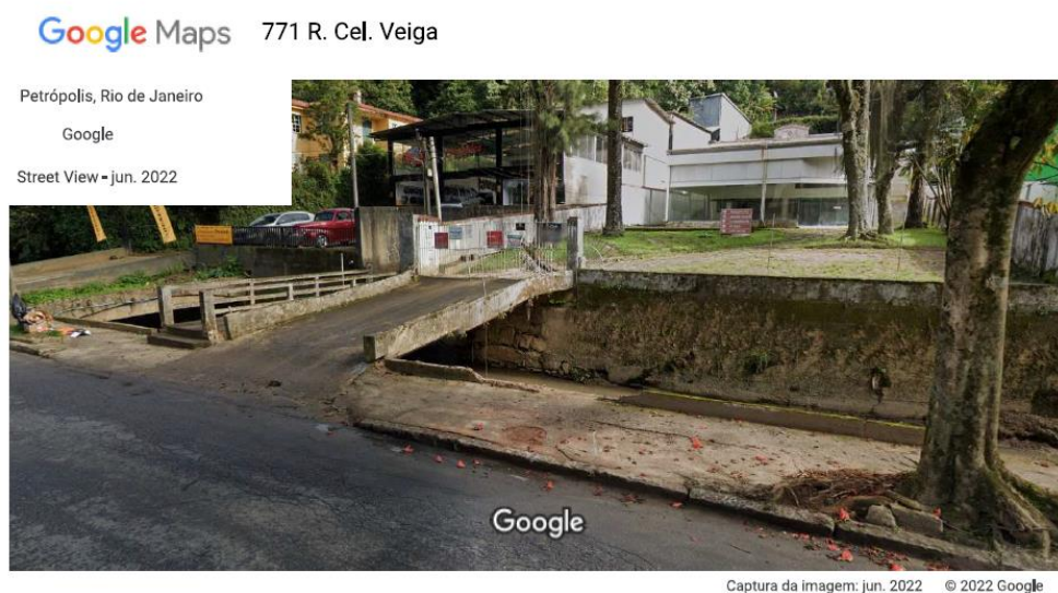
Figura 26 - Pontes na margem direita do rio Quitandinha, no nº 771 da rua Coronel Veiga, bairro de Valparaíso, Petrópolis, RJ. Fonte: Google Maps
