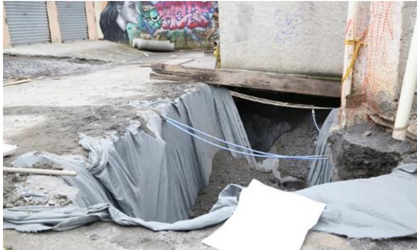
Figura 21 - Abertura de crateras no trajeto do túnel extravasor do rio Palatino, no bairro de Quissamã. Fonte: Diário de Petrópolis (2020)
