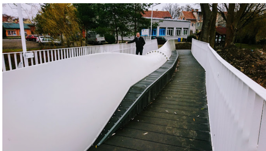
Figura 20 - Primeira fonte feita reutilizando pás eólicas 2
