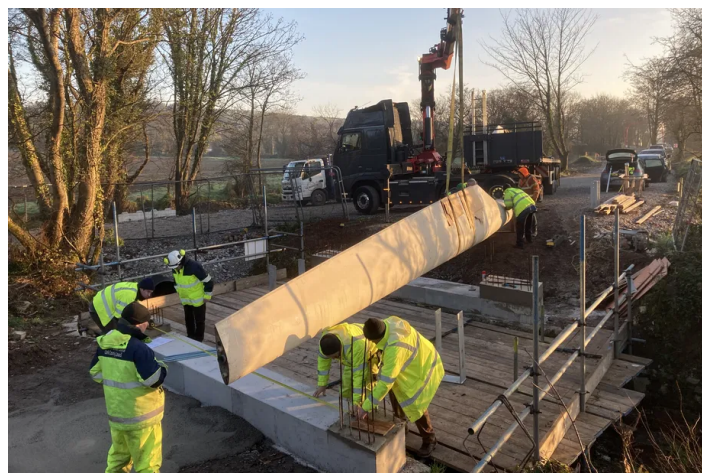
Figura 22 – Construção de ponte de pedestre reutilizando pás eólicas 2
