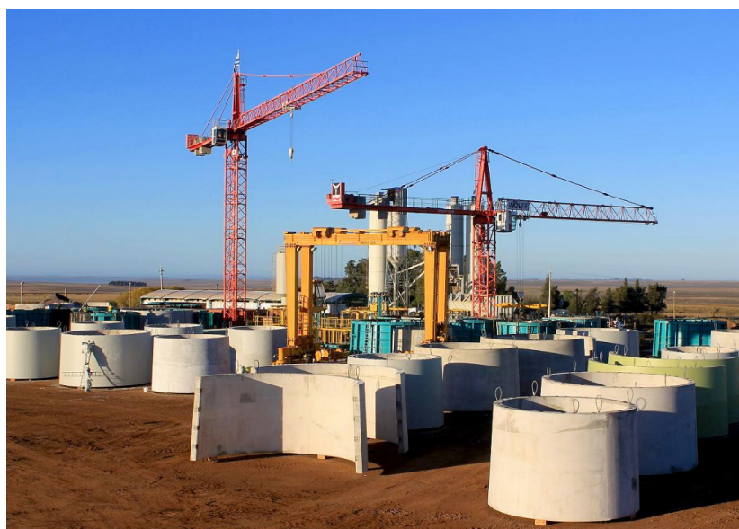
Figura 11 – Torre de concreto armado
