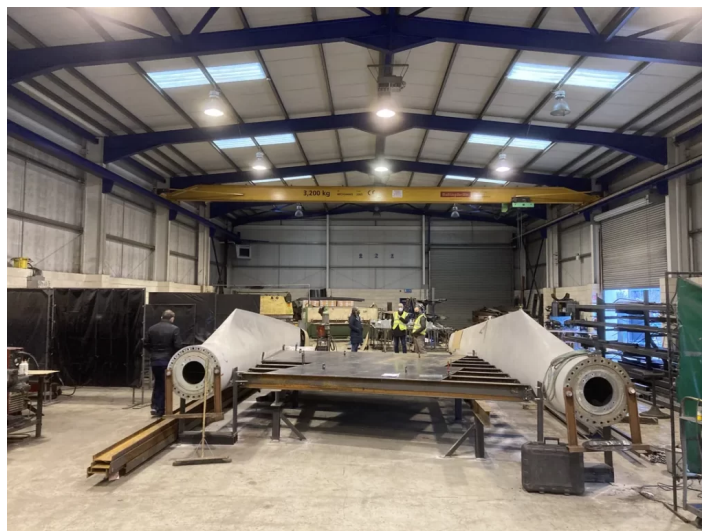
Figura 22 – Construção de ponte de pedestre reutilizando pás eólicas 1
