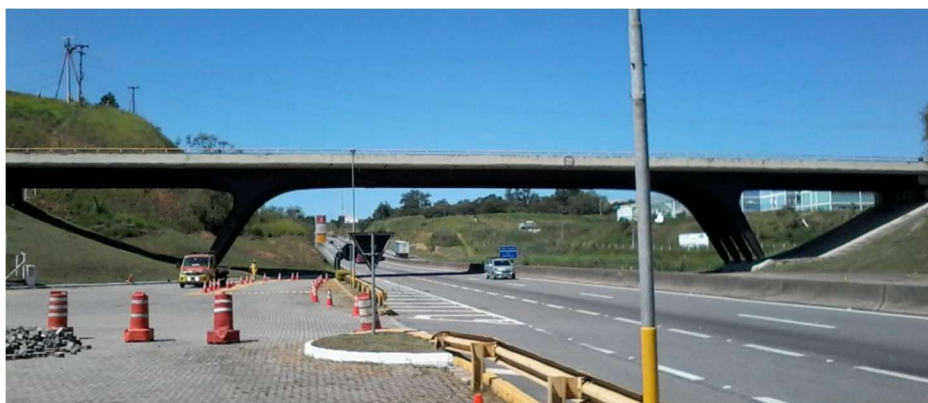
Figura 3.4 – Viaduto Cidade do Aço.
