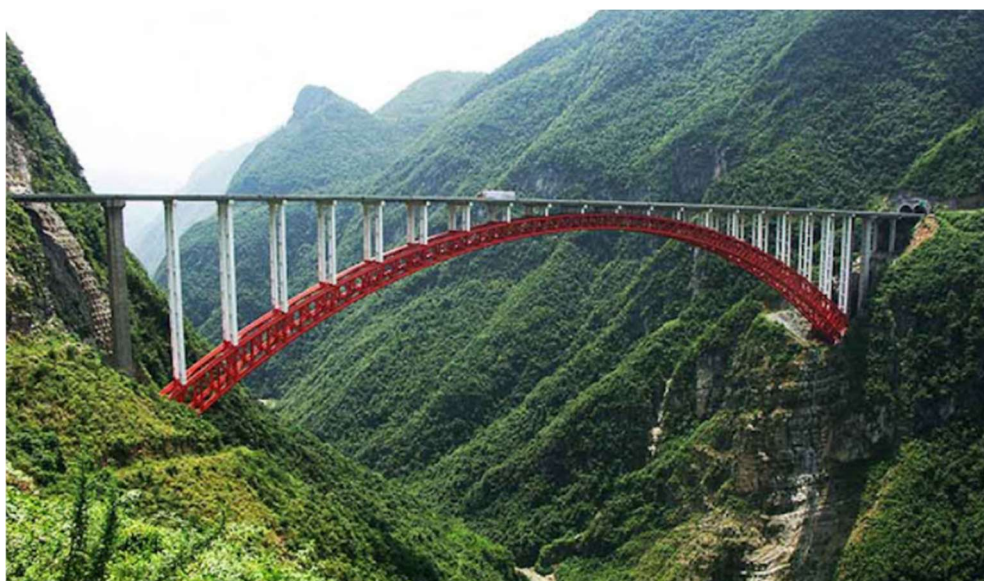
Figura 3.5 – Ponte em arco.
