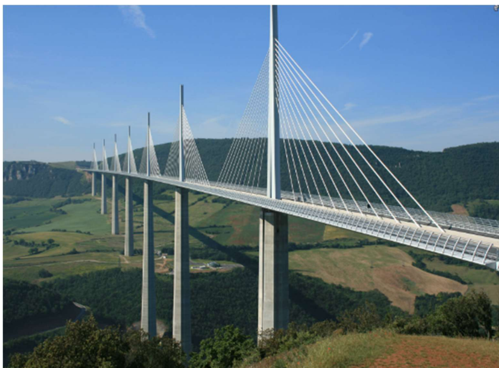
Figura 3.6 – Viaduto de Millau.
