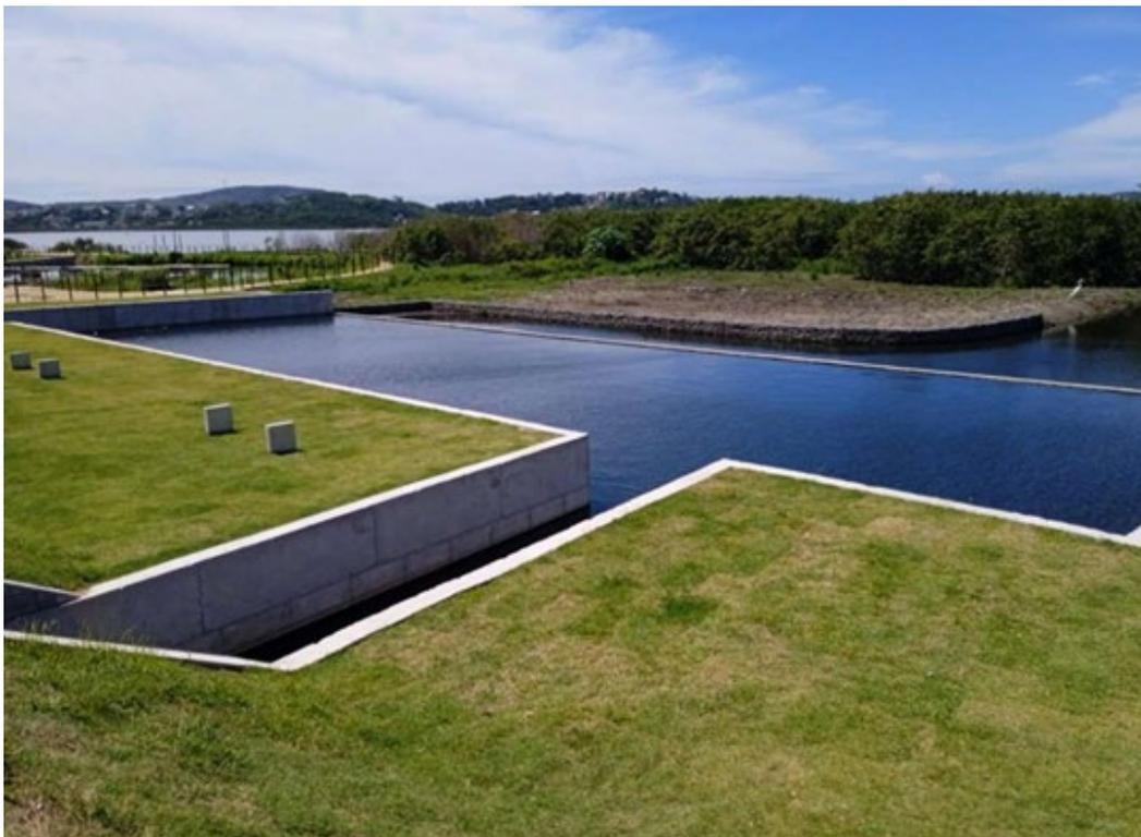
**Figura 3.15** Vertedouro construído e bacia de recepção em funcionamento. Fonte: Projeto Parque Orla Piratininga
