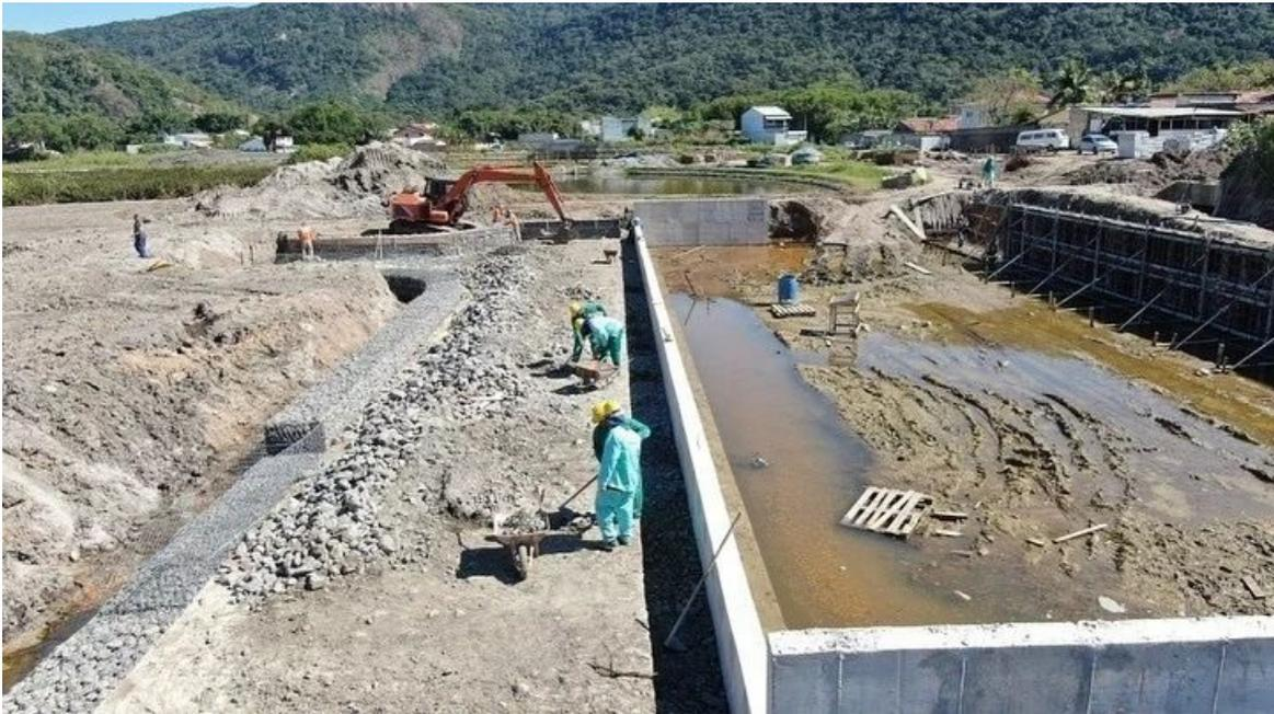
**Figura 3.14** Construção do Vertedouro e da bacia de recepção. Fonte: Projeto Parque Orla Piratininga
