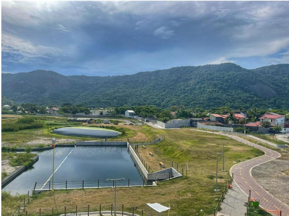
Figura 3.16 Vertedouro e bacia de recepção construídos e em funcionamento. Fonte: Projeto Parque Orla Piratininga
