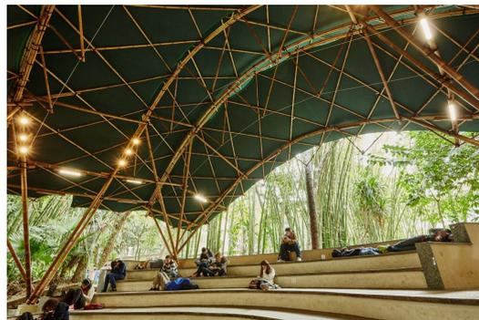
Figura 104 - Estrutura de bambu do anfiteatro da PUC-Rio. Fonte: (BAMBUTEC, s.d.)
