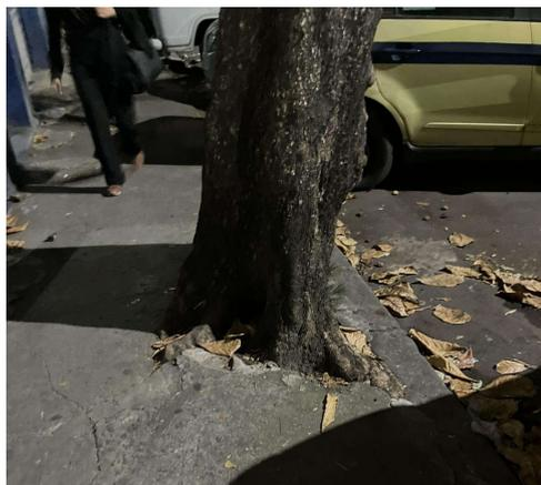
Figura 62 - Raiz de árvore causando desnivelamento na Rua Assunção. Fonte: Acervo pessoal.
