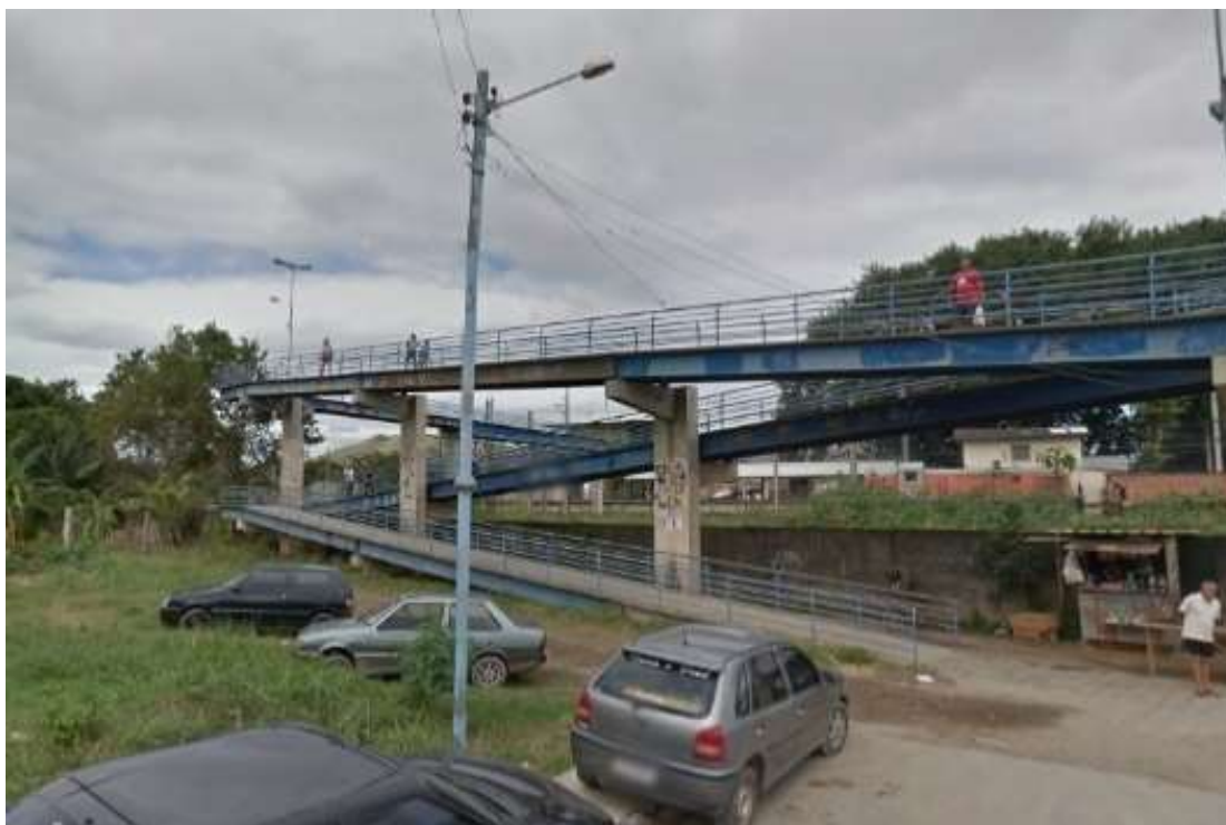
Figura 24. Acesso a estação ferroviária pela Rua Dona Laura Schiavo
