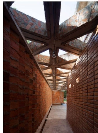
Placas moldadas em obra compostas por tijolos de demolição e concretos, estas placas compõem os lados dos módulos triangulares. Fonte: Revista Arquitectura Viva .
