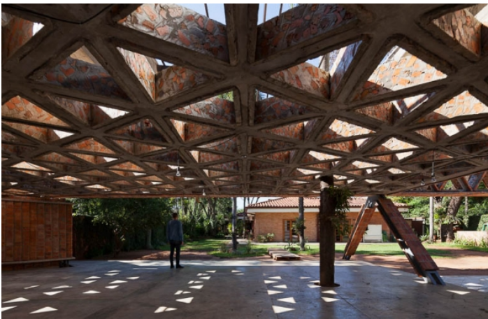
Placas moldadas em obra compostas por tijolos de demolição e concretos, estas placas compõem os lados dos módulos triangulares. Fonte: Revista Arquitectura Viva .
