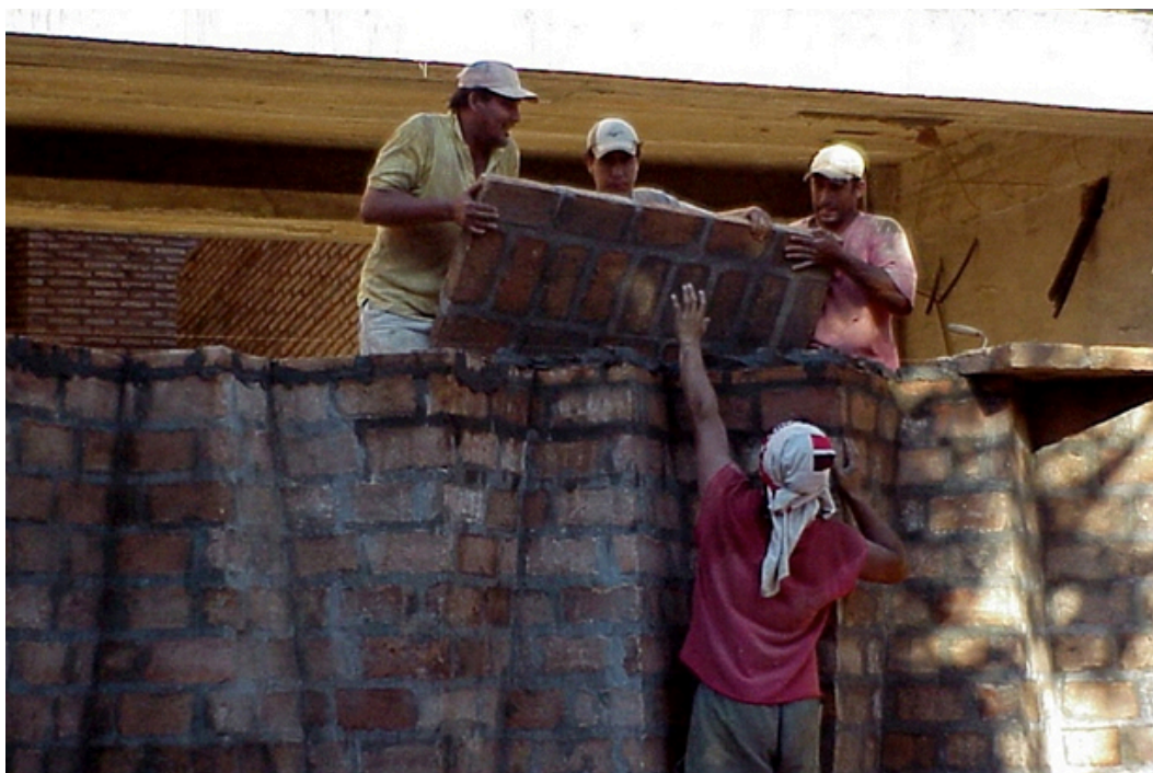
Casa Esmeraldina, montagem da fachada. Fonte: arquiscopio.com
