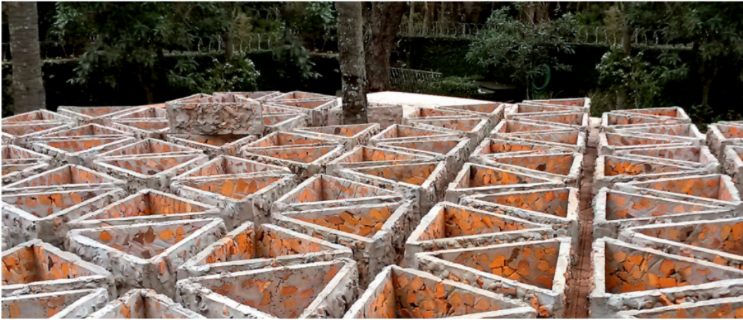
Placas moldadas em obra compostas por tijolos de demolição e concretos, estas placas compõem os lados dos módulos triangulares. Fonte: Revista Arquitectura Viva .
