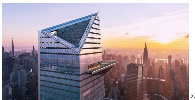
Figura 13 - Vista do deck de observação mais elevado do ocidente, instalado no Hudson Yards (New York City)
