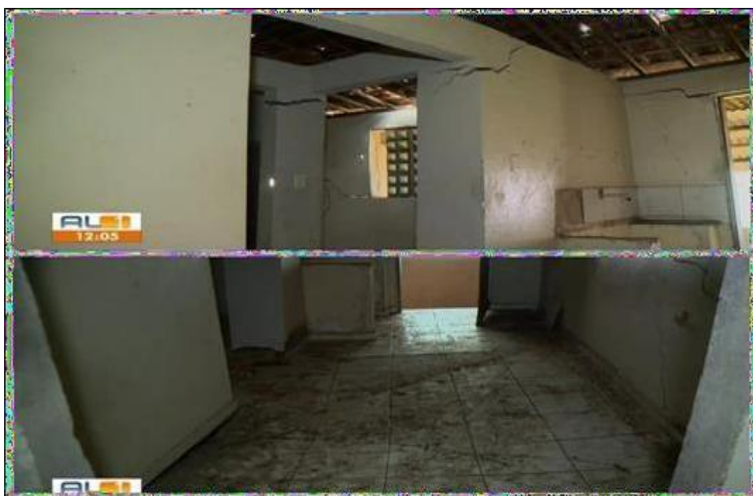
Figura 33 - Rachaduras e afundamento do piso em imóvel no Mutange Fonte: Gazeta de Alagoas (2019)
