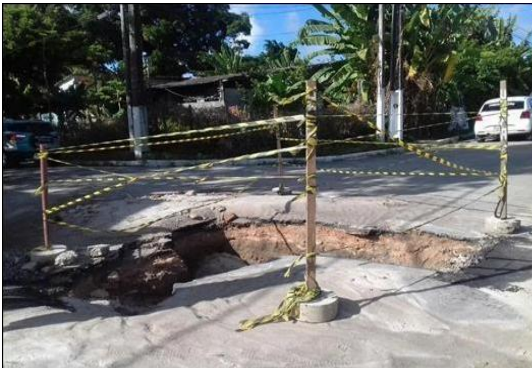
Figura 45 - Parte do asfalto cedido após tremor no Bairro Pinheiro Fonte: G1 AL (2008)
