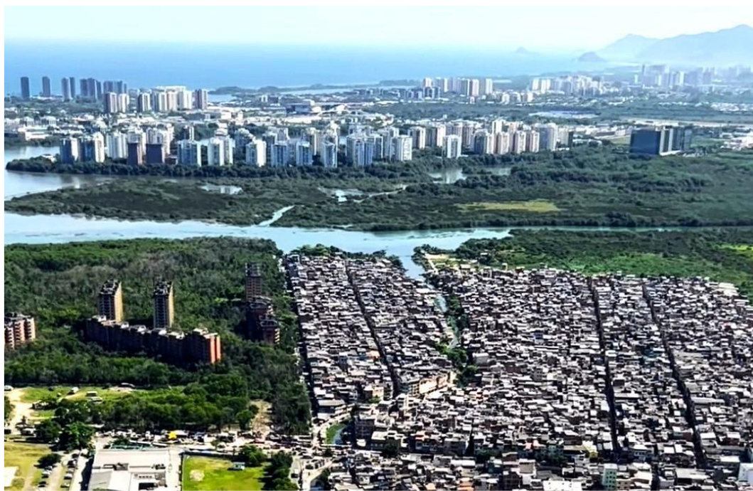
Figura 51: Vista aérea da Gleba F no meio da foto, em 1º plano a favela Rio das Pedras à beira da
