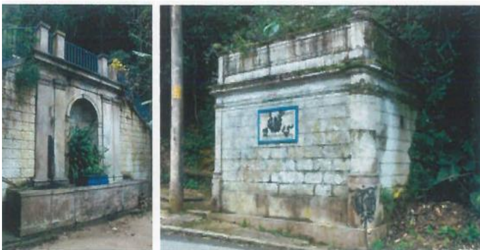
Figura 13: Reservatório da Carioca localizado na Rua Almirante Alexandrino 5.440 – Santa Teresa Fonte: Obtida no processo de tombamento E-18/001/449/2018 – INEPAC
