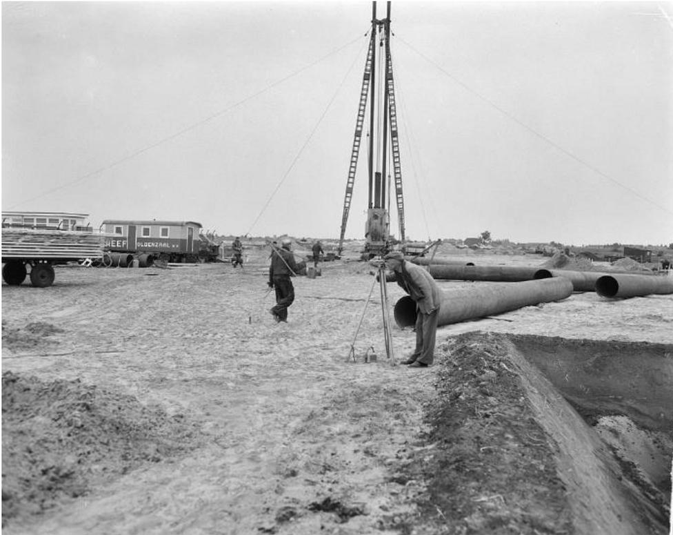
Figura 6-11: Figura mostrando a construção do gasoduto do Campo em 1963. Adaptado de <http://proxy.handle.net/10648/aa3af0d6-d0b4-102d-bcf8-003048976d84>.
