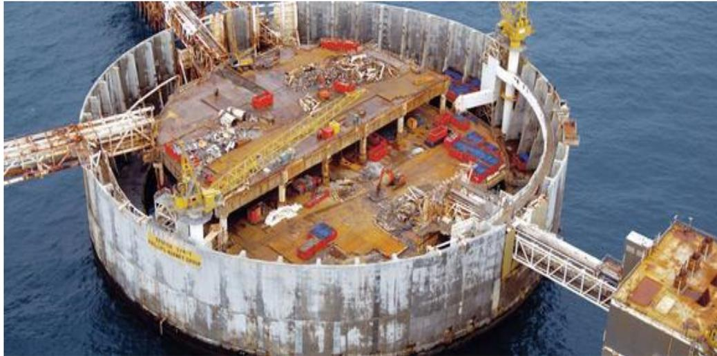
Figura 6-6: Barreira construída para proteger o tanque das ondas. Os engenheiros calcularam que a subsidência chegaria a 6 m <https://www.ice.org.uk>
