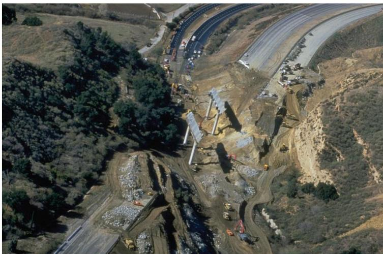
**Figura 1.2** – Após o terremoto de Northridge em 1994, recalques significativos sismicamente induzidos observados em aterros. (Fonte: Britannica. Disponível em: <https://www.britannica.com/event/Northridge-earthquake-of-1994>. Acesso em: 15 jul. 2023).
