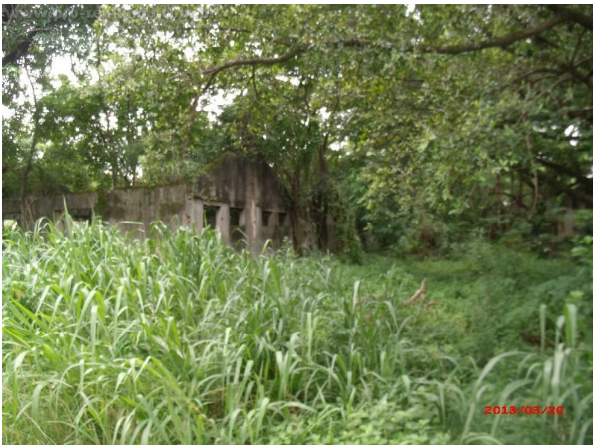
Figura 27: Área da Antiga Fábrica de Cartuchos abandonada. Fonte: Blog Pró Realengo, 2013.
