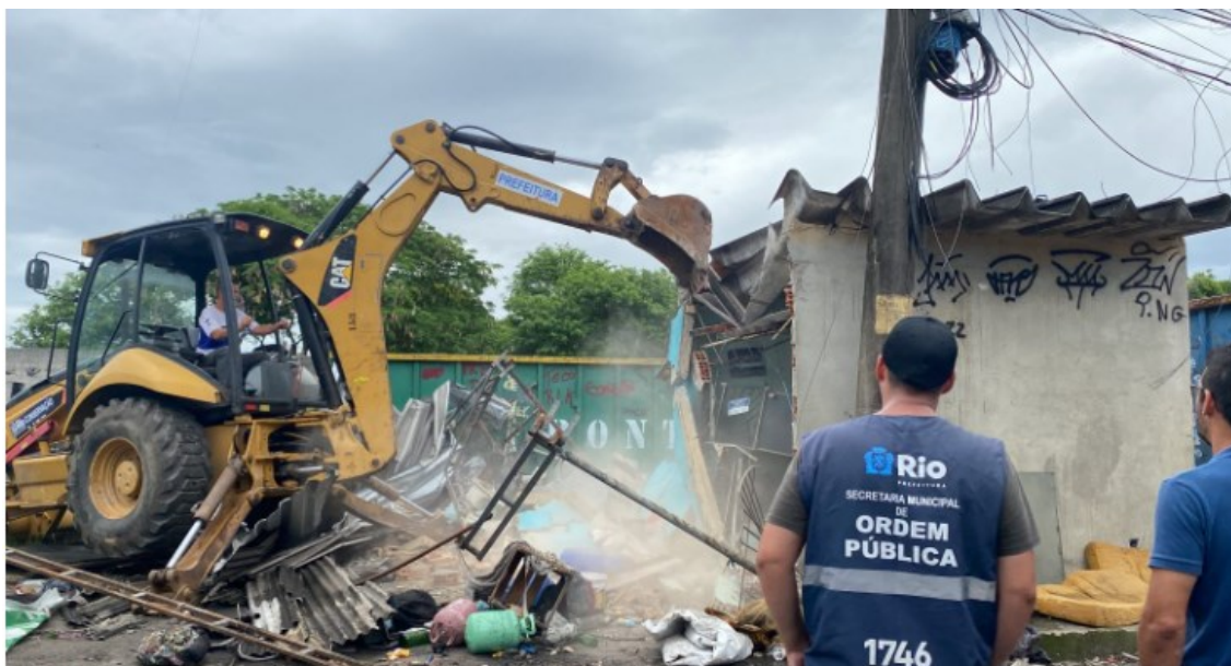
Figura 36: Demolição de construções irregulares para início das obras do Parque Realengo Susana Napolini.
