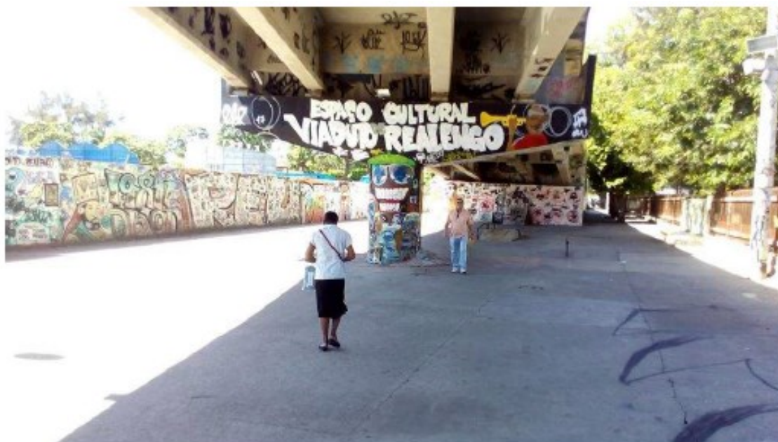
Figura 8: Viaduto de Realengo. Fonte: Sandro Henrique Rosa, 2018.
