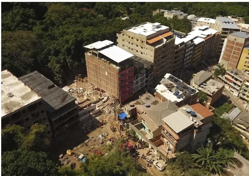
Figura 23. Escombros do desabamento dos prédios na Muzema.
