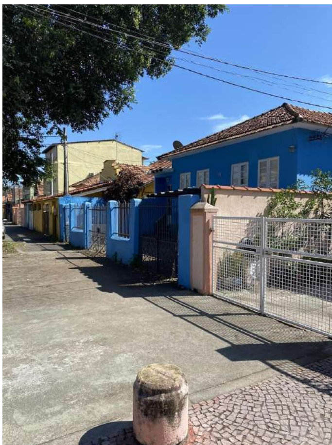
Figura 41: Estado de conservação das residências. Rua Eng. Emílio Baumgart - Área 01 (A1), 2023. Fonte: acervo pessoal.
