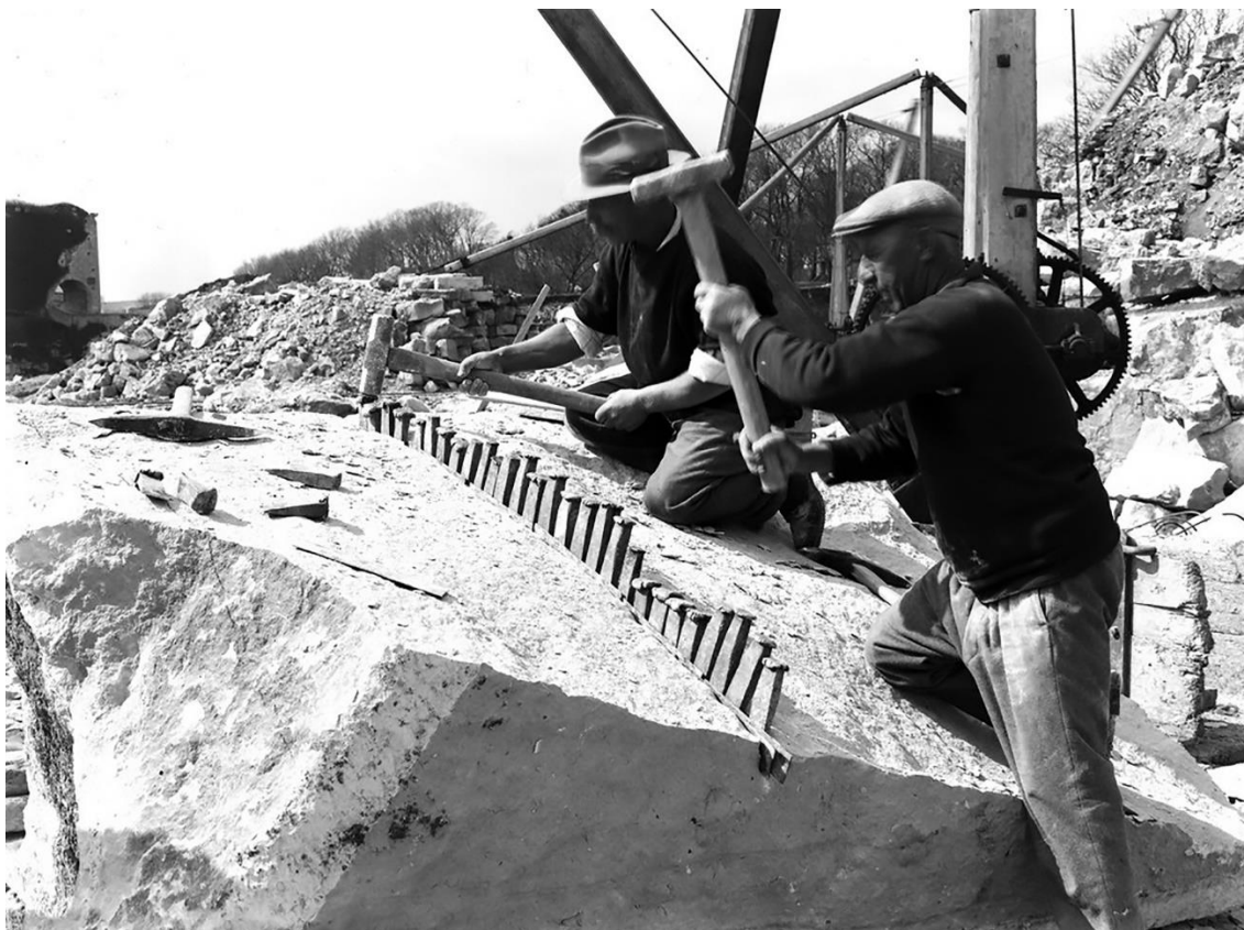
Figura 7: Corte de um bloco de rocha extraído de pedreira na ilha de Portland, na Inglaterra. J. Rhodes, 1930. Fonte: Acervo British Geological Survey.
