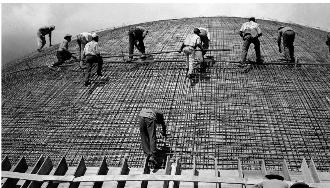
Figura 8: Execução da armação de aço para a concretagem das cúpulas do congresso nacional, em Brasília. Marcel Gautherot, c. 1958. Fonte: Acervo IMS
