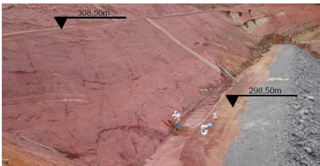
Figura 3.6 - Traços das estruturas reliquias na face do talude (Machado, 2012).
