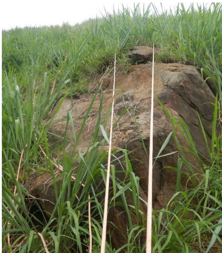
Figura 4.4 – Bloco com risco de desprendimento [98]
