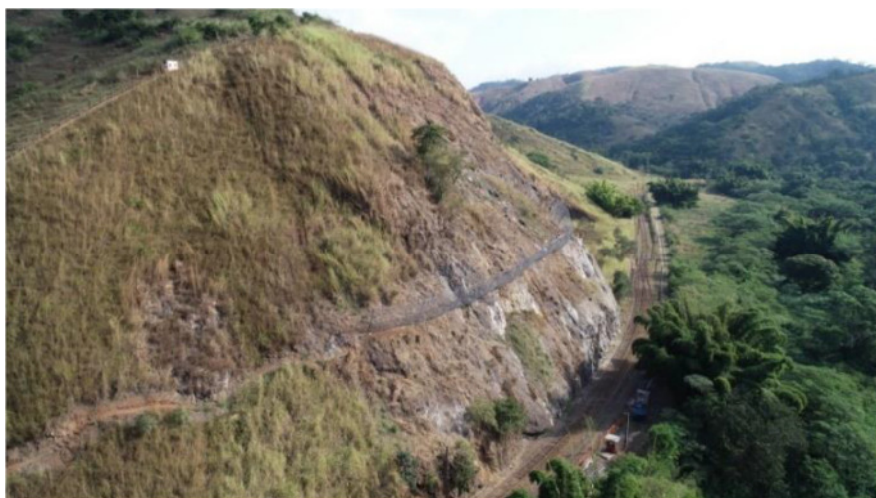
Figura 4.1 – Talude rochoso às margens da linha férrea [98]
