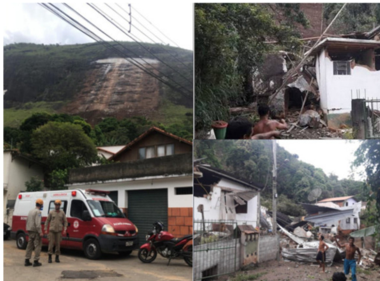
Figura 1.2 – Cicatriz do deslizamento à esquerda; à direita: destruição das casas. Petrópolis, 2019 [13]
