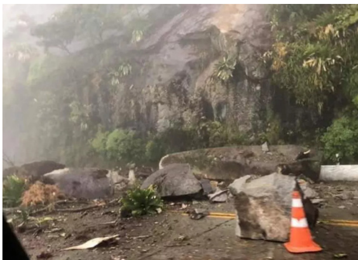
Figura 1.7 –Trecho da BR-116 parcialmente interditado após blocos de rocha atingiram a pista. Teresópolis, 2019 [19]
