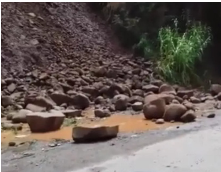
Figura 1.6 – Blocos de desprendem da encosta e atingem pista da RJ-125. Vassouras, 2022 [18]
