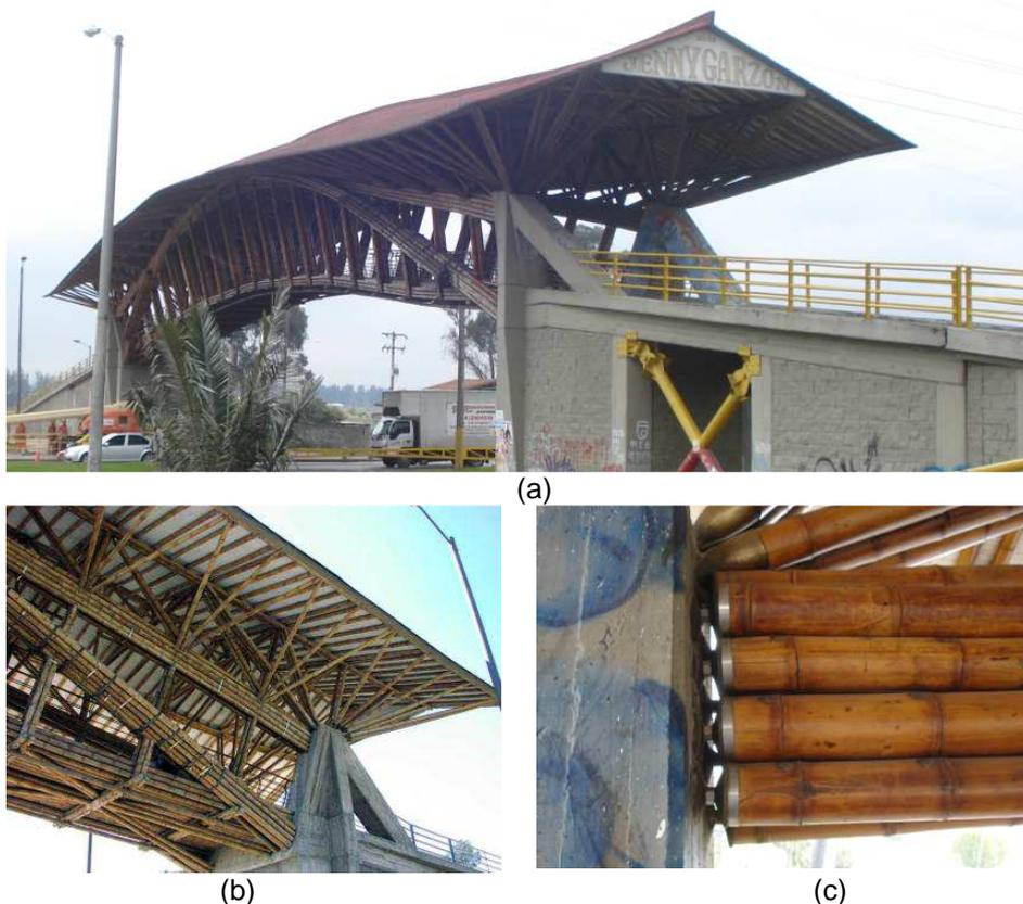
Figura 2.18 – Usos do bambu. (a) Vista geral de ponte de pedestre construída com bambu e concreto. (b) Interação bambu concreto. (c) União pilar de concreto com viga de bambu (Fonte: <http://www.skyscrapercity.com/showthread.php?t=386606>).
